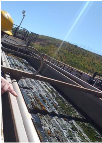
Figure II.4 : Plaques du CPI utilisées pour la séparation huile/eau.
