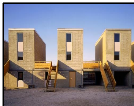
Figure 68 : Façade libre à modifier (QUINTA MONROY).
