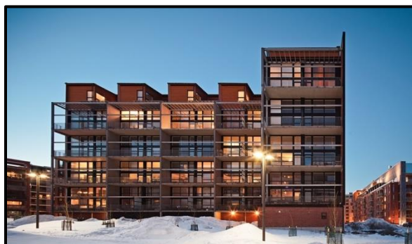
Figure 67 : Façade fixe (120 maisons).
