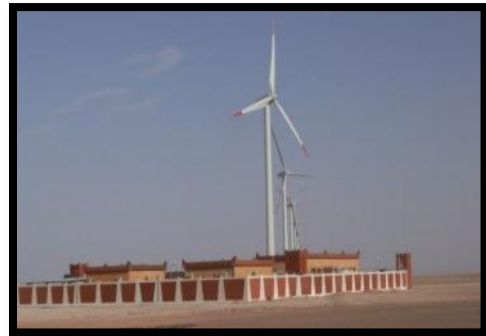
(Figure I.7 : Une ferme Éolienne)
