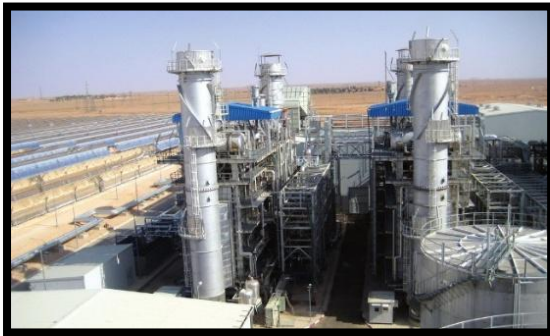
(Figure I.6 : Une centrale hybride Solaire-Gaz)
