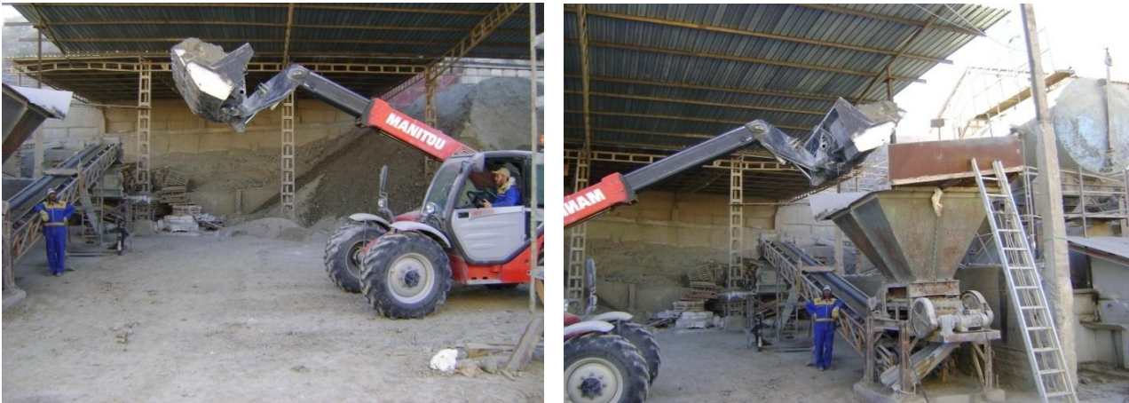
Figure N° 06 : Chargement de la trémie d'alimentation par engin multifonction
