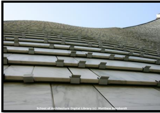
Figure 57: de carreaux de marbre
