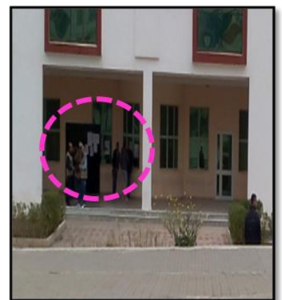
Figure 11: l'entrée principale de l'école d'architecture
