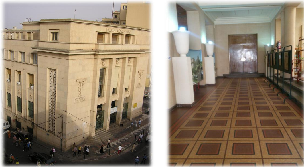
Figure 5.53 : L'édifice depuis l'extérieur et l'intérieur
