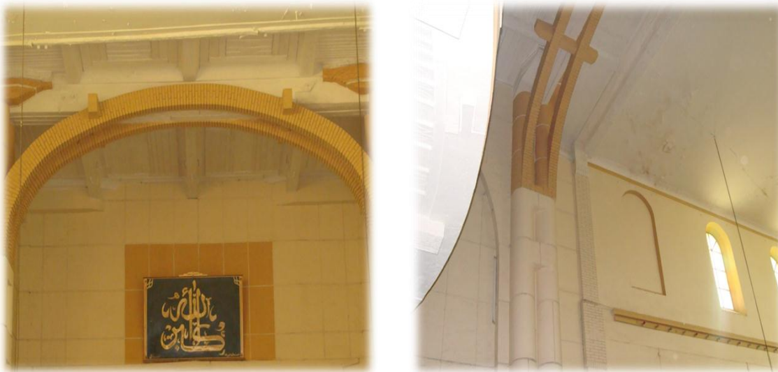
Figure 5.50 : La partie construite en béton
