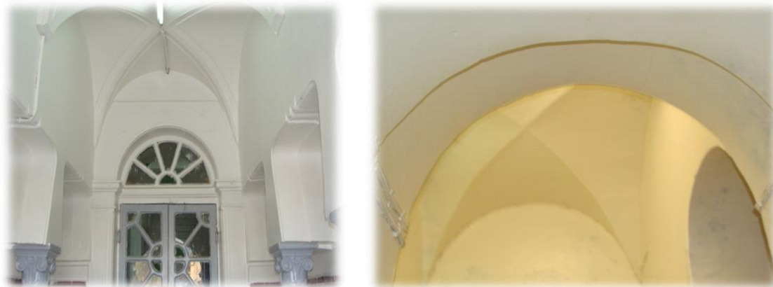
Figure 5.36 : Les voûtes de la salle tiède ont pour rôle technique Source : Auteur du mémoire
