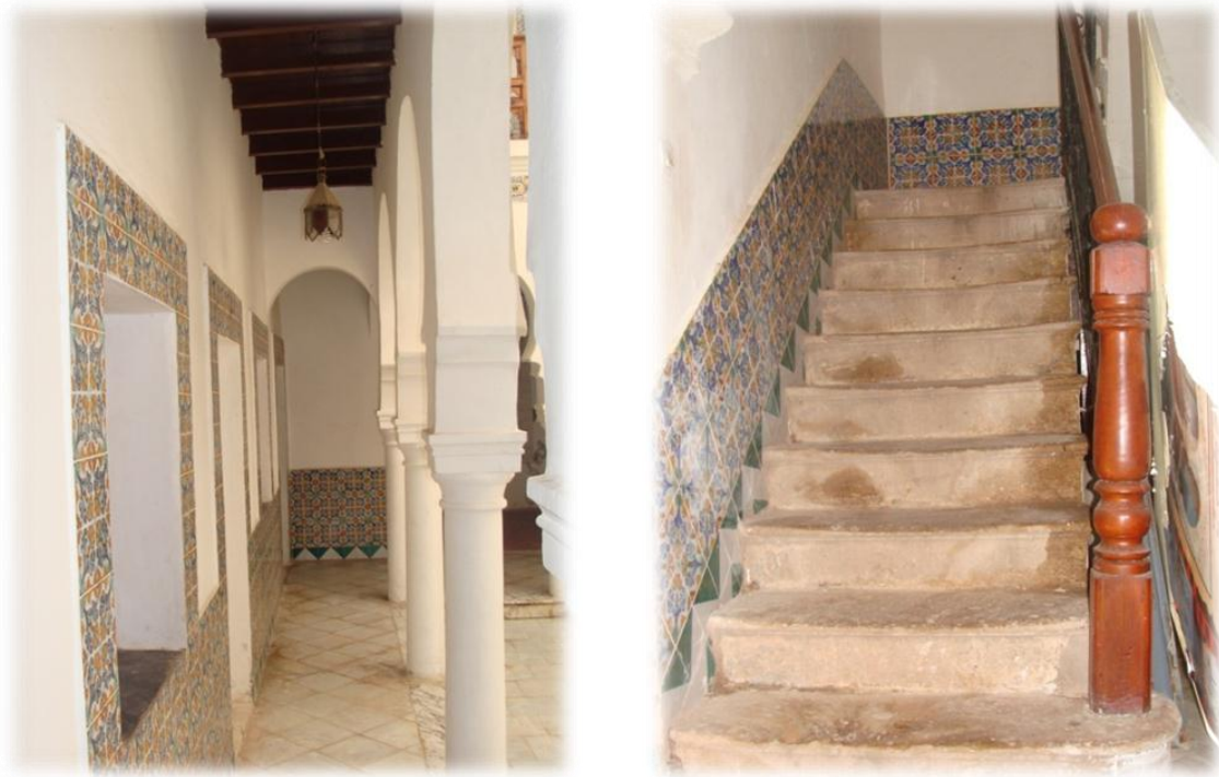
Figure 5.27 : Vue sur l'escalier et le plancher en bois
