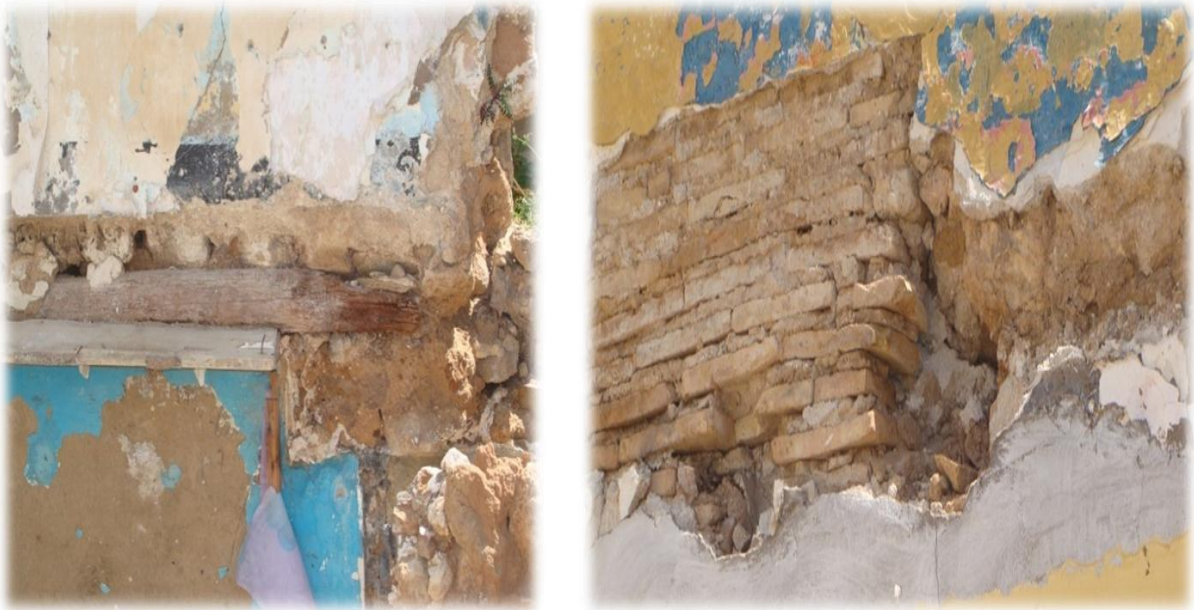
Figure 5.12 : Constitution des murs [Pierre + Brique pleine + Mortier]
