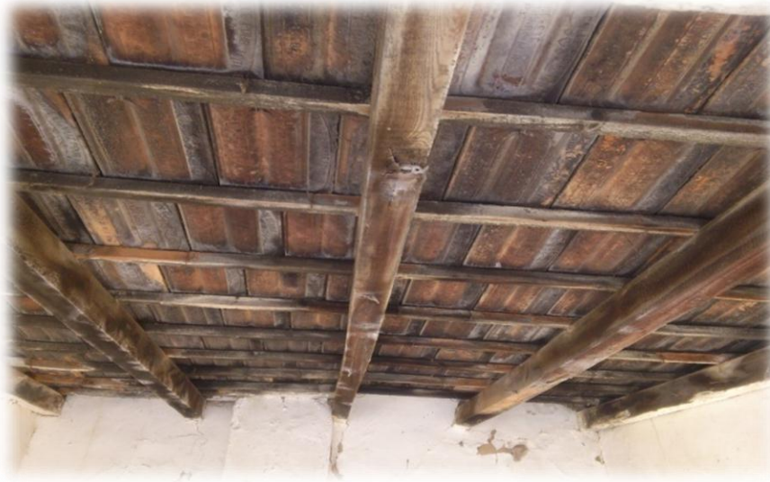
Figure 5.39 : Un plancher en poutrelles en bois
