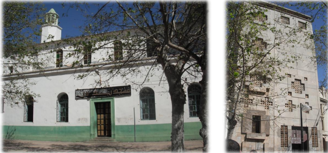
Figure 5.43 : Les deux compartiments de l'édifice (mosquée + annexe de la municipalité locale)
