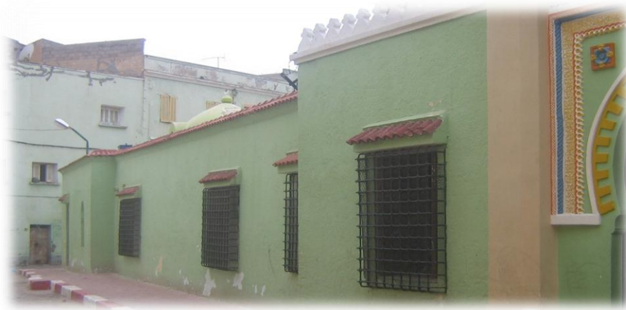
Figure 5.8 : le traitement des fenêtres après la restauration
