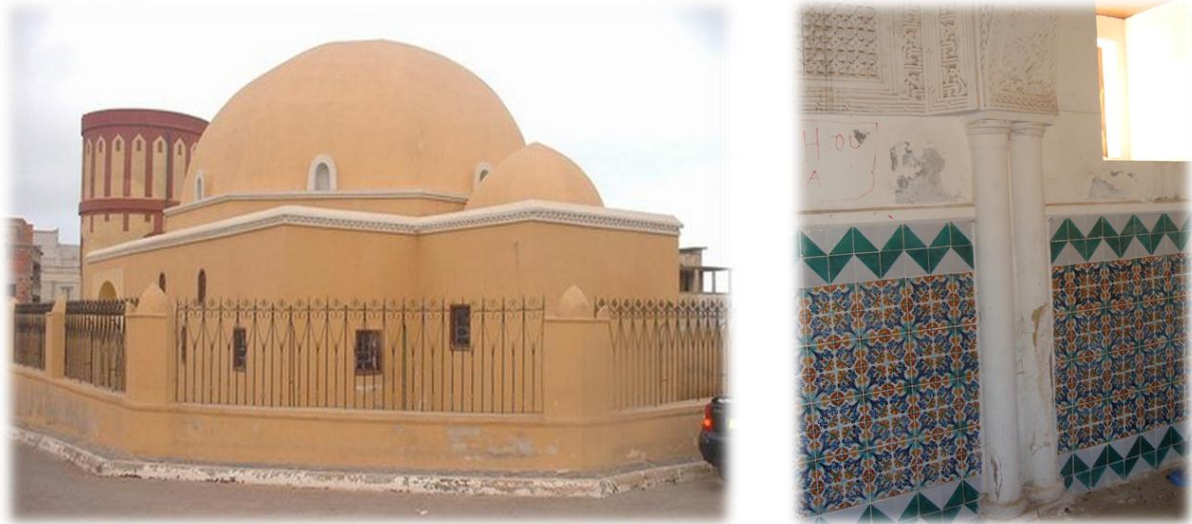
Figure 5. 32 : Le tombeau du bey Mustapha al-Ahmar après la restauration
