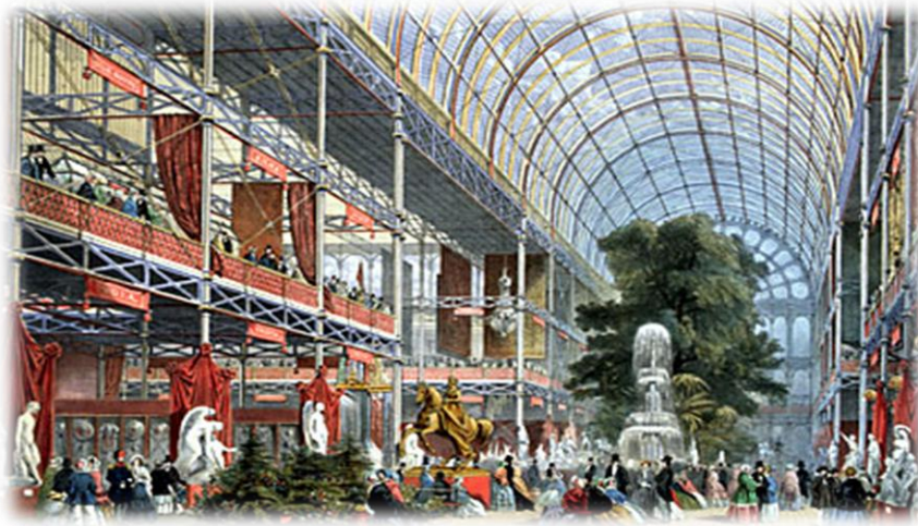
Figure 3.5 : L'emploi du verre, comme matériau de construction dans les structures métalliques, à partir du XIX e siècle. Exemple : Le Crystal palace, réalisé par J.Paxton, Londres, en1851
