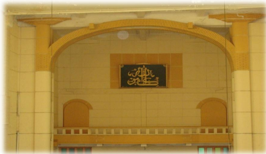
Figure 5.48 : Le balcon d'orgue à l'intérieur de la salle de prière actuellement suspendu
