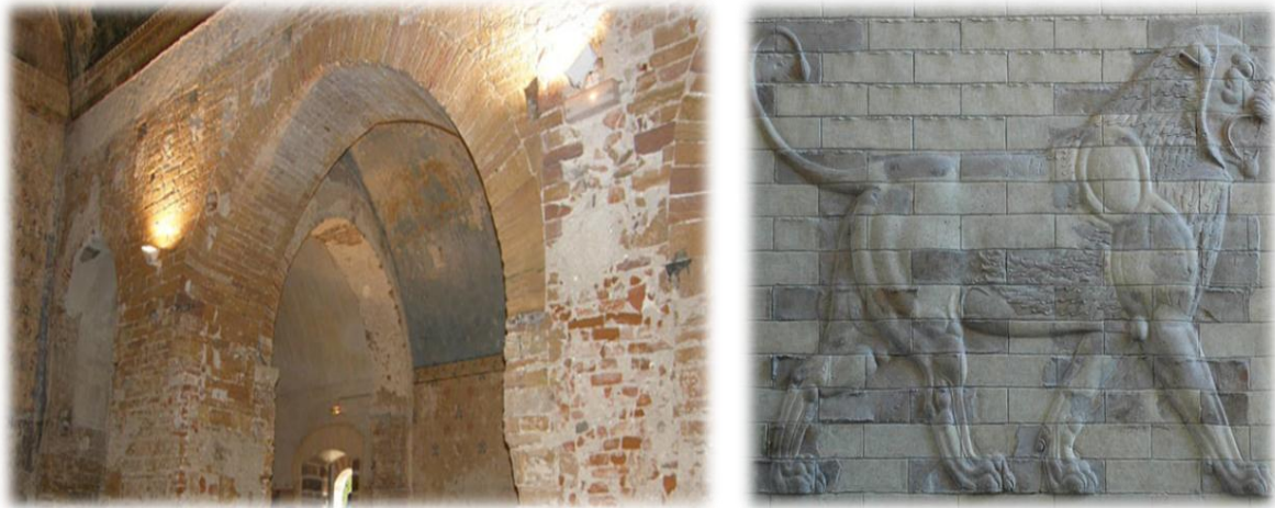
Figure 3.3 : Utilisation de la brique pour la structure et le revêtement
