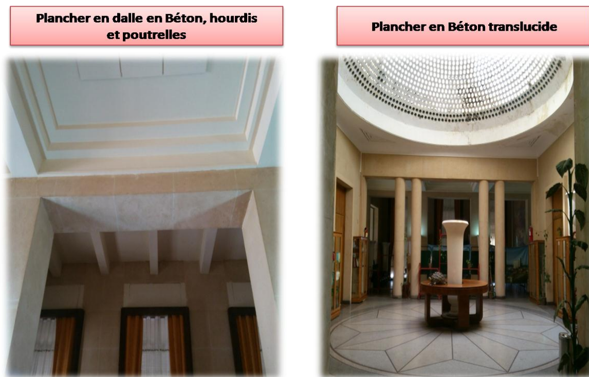
Figure 5.56 : Les types des planchers en béton
