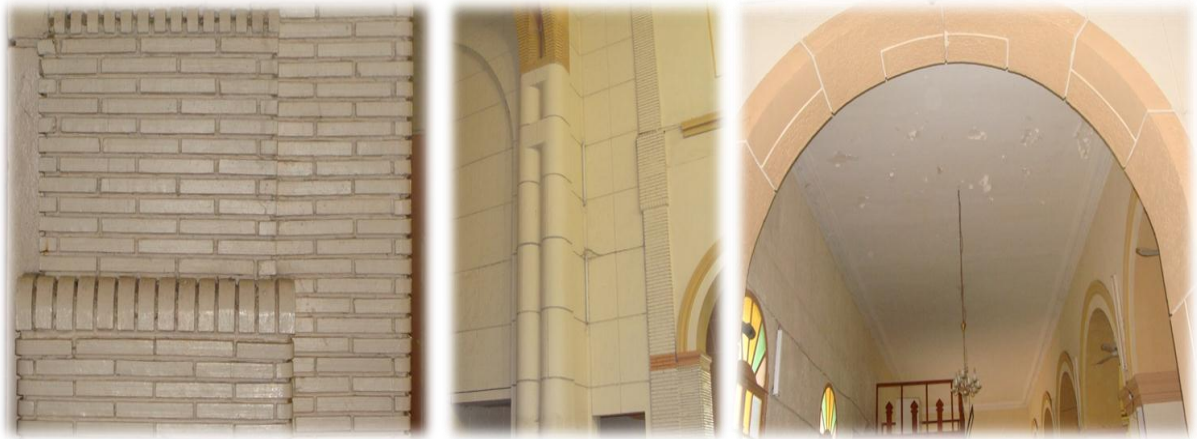
Figure 5.51 : L'effet esthétique des matériaux traduit par les différents types d'appareillage Source : Auteur du mémoire
