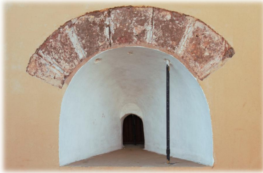
Figure 5.19 : Détail sur arc en brique pleine
