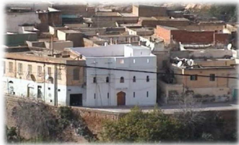
Figure 5.22 : Vue générale sur la maison « Dar-el-kaïd »
