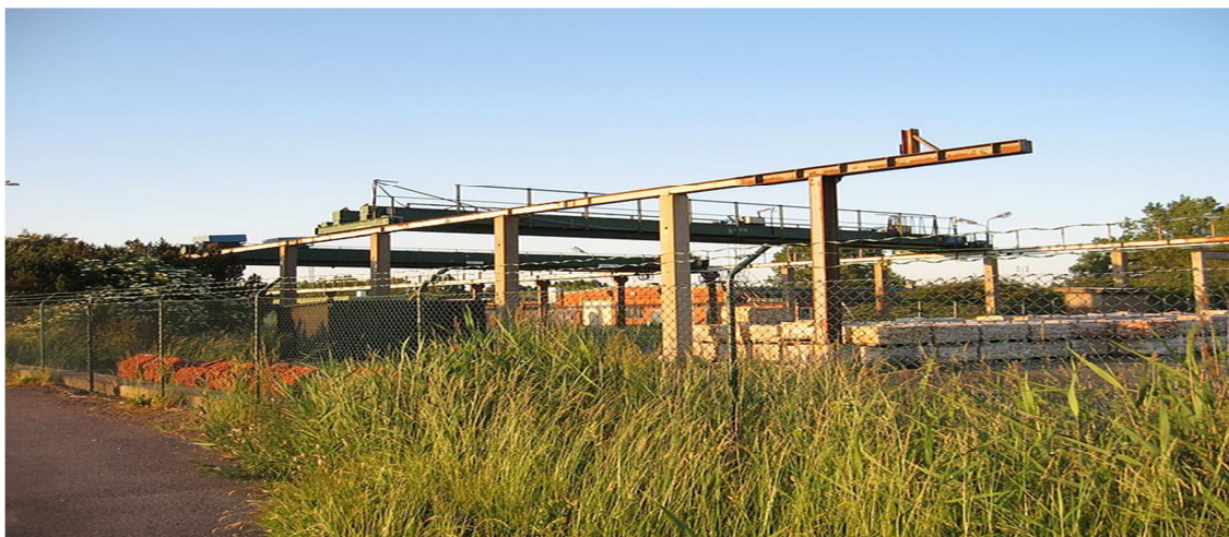
Figure I-1 : Pont roulant industriel
