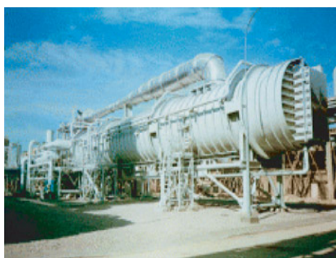
(a) vue latérale d'une unité
