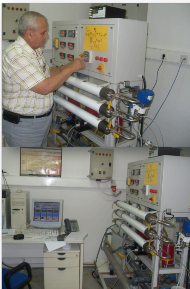
Figure IV.2. Photos du pilote (RO)
