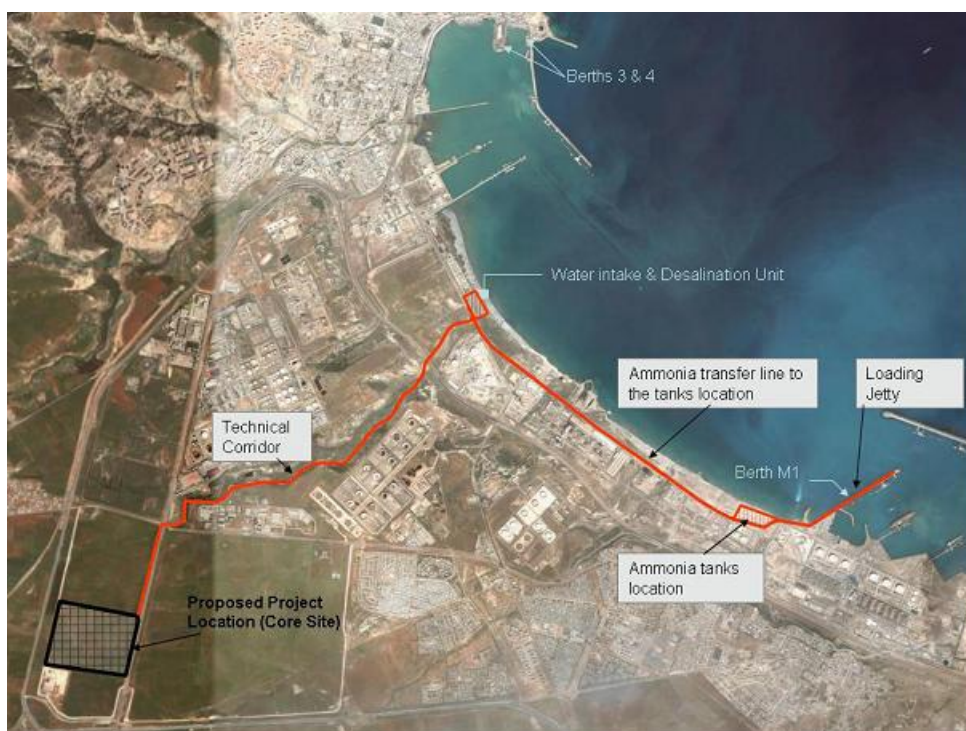
Figure I.1. Situation géographique du complexe
