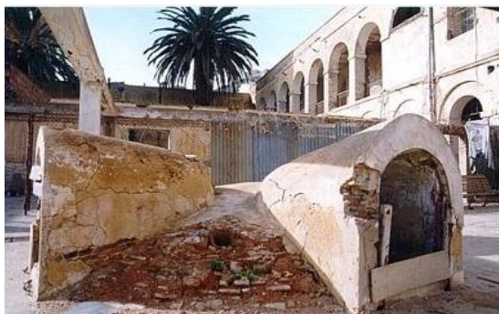
Fig. 30: Les bains Turcs bâtis.
