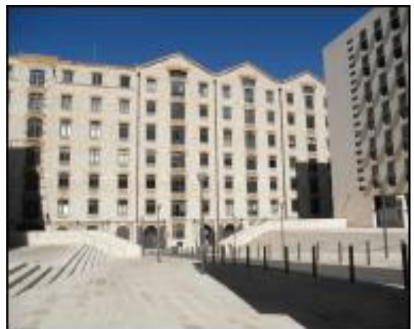
Fig.11: Vue sur l'immeuble des docks.
