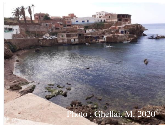
Figure 25 : La station de Kristel.
