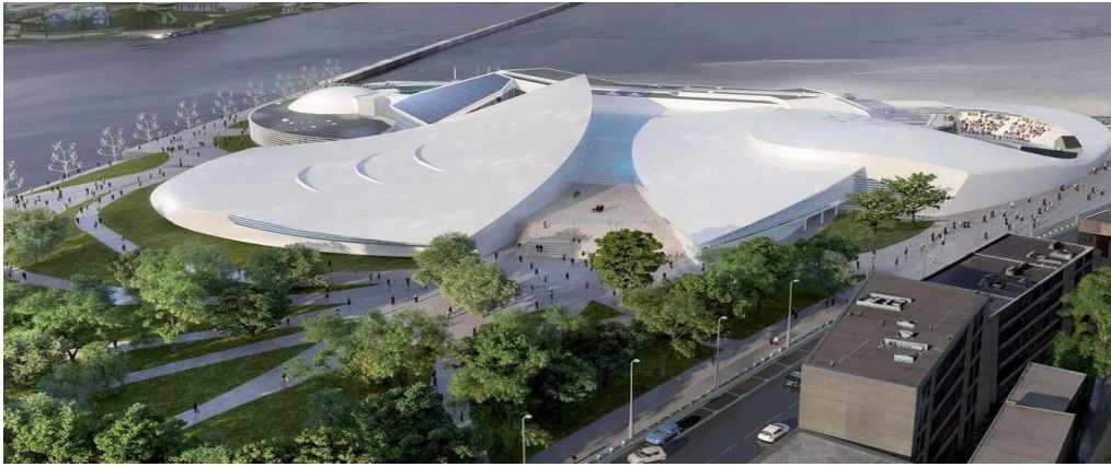
Fig.10 : L'implantation d'un immeuble qui est 75% vitré
