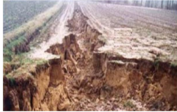
photo 3. Erosion par ravinement
