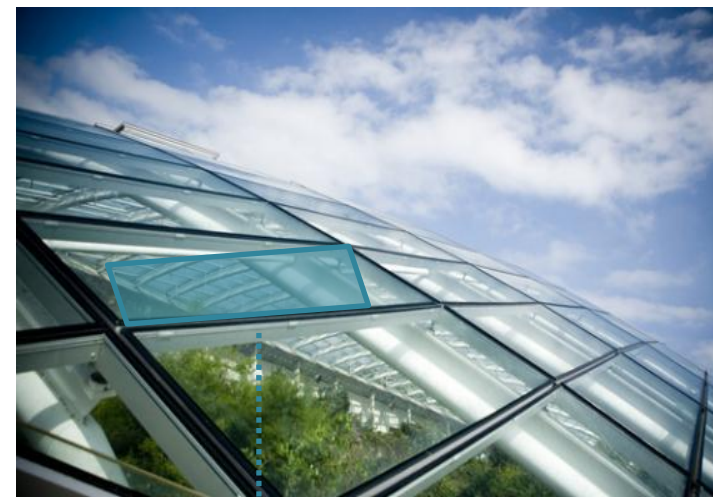
Constitué de 785 panneaux de verre Bonne ventilation naturelle en été grâce aux panneaux de verre qui s'ouvrent.
