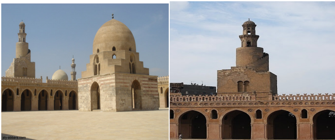
Fig. I.25 : Le Minaret de La Mosquée de Ahmed ibn Touloun
