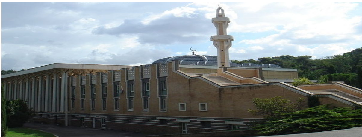
Fig. I.6 : La Mosquée de Rome
