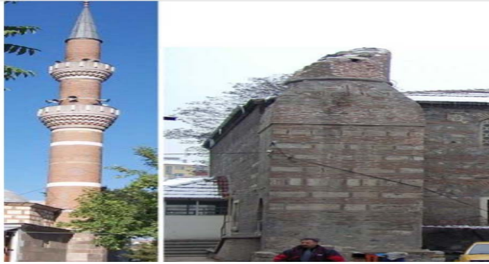
Fig II.1. Exemples de minarets de briques de maçonnerie historiques en Turquie: (a) Hacı Bayram mosque, Ankara, (b) Semsî Ahmet Pasa mosque, Bolu
