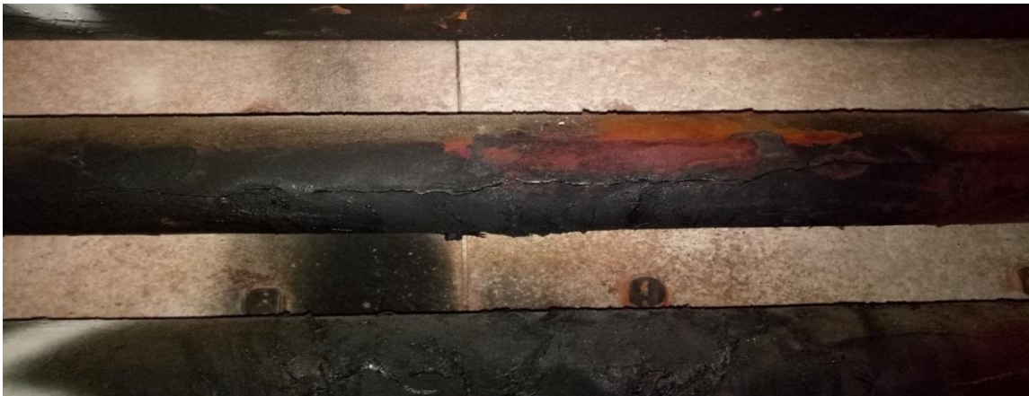
Figure II.4.a.b- Les tubes de fours H101 avant le changement.
