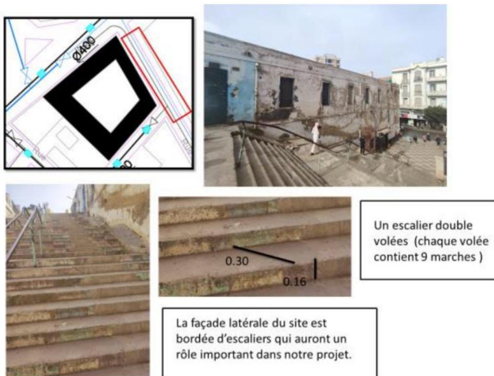
Figure 42 : Détaille de l'escalier urbain
