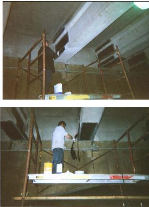
Figure II. 21. Réparation de la poutre PC en utilisant des tissus en CFRP [7].
