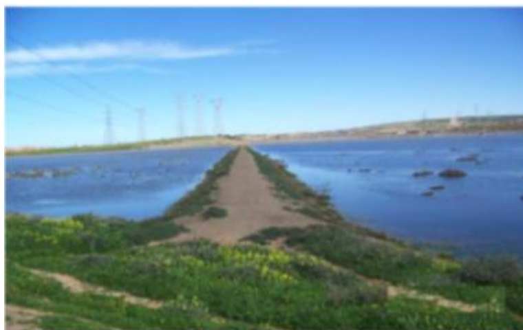
Figure n° 15: Le passage du gazoduc dans le marais de la Macta
