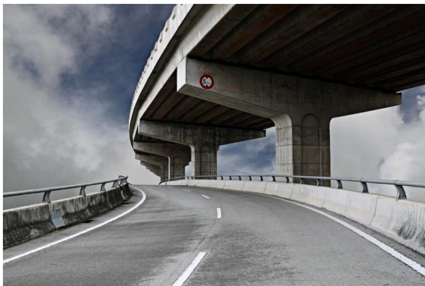
Figure V.13: Glissières en béton
