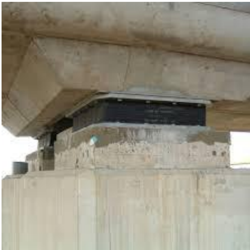
Figure V.1: appareil d'appui
