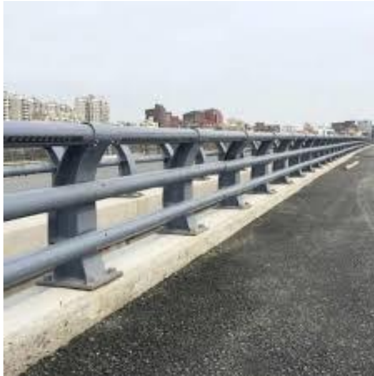
Figure V.14: Barrières de sécurité renforcées
