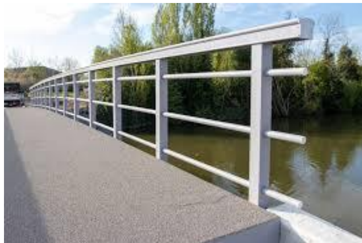
Figure V.9: Garde-corps à lisses horizontales
