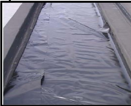
Pose d'un film polyéthylène
