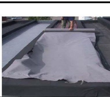
Placement du voile filtrant
