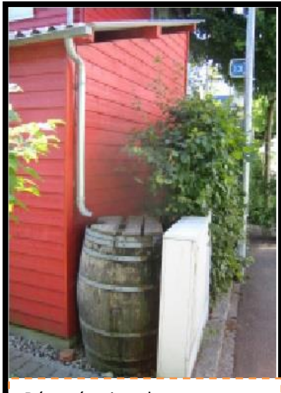
Récupération des eaux
