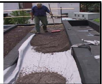
Mise en œuvre du substrat
