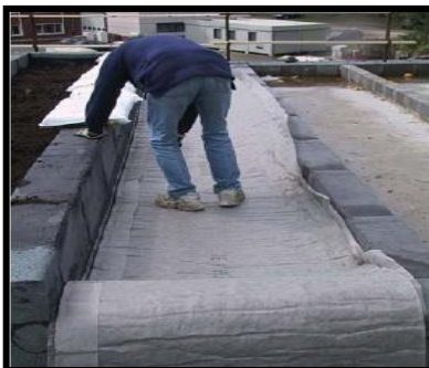
Drainage sous forme de treillis en PE avec voile filtrant
