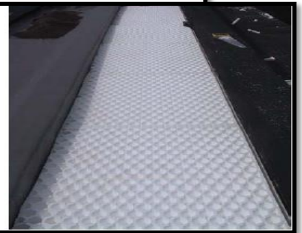
Drainage sous forme de plaques à excroissances en EPS
