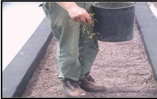
Mise en place de la végétation
