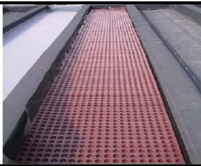
Drainage sous forme de plaques à excroissances en PVC rigide
