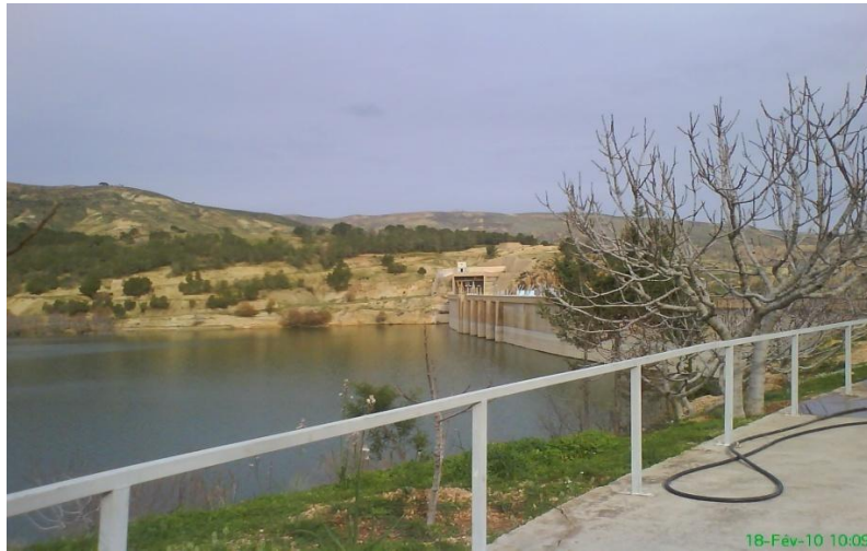
Figure I.34 : Vue du côté interne de la digue du barrage Chorfa II
