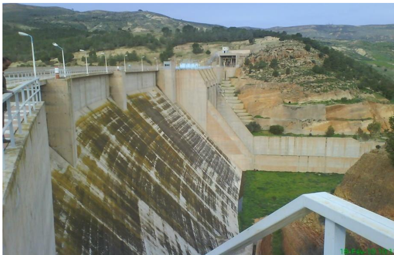
Figure I.35 : La digue du barrage Chorfa II
