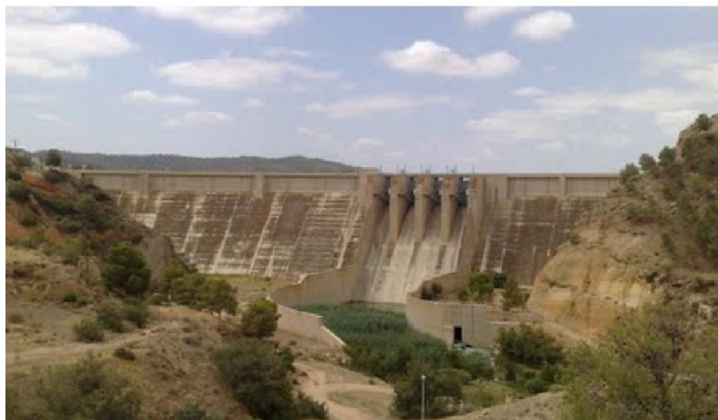
Figure I.33 : Vue générale du barrage Chorfa II
