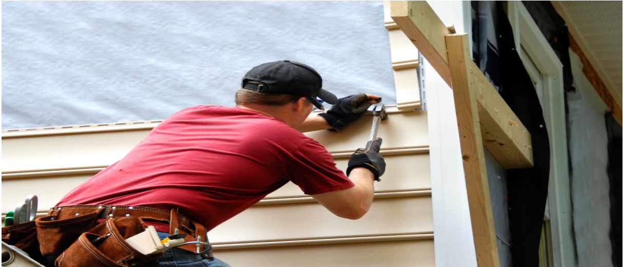
Figure 4.9 : traitement d'infiltration avec un revêtement de façade imperméable
