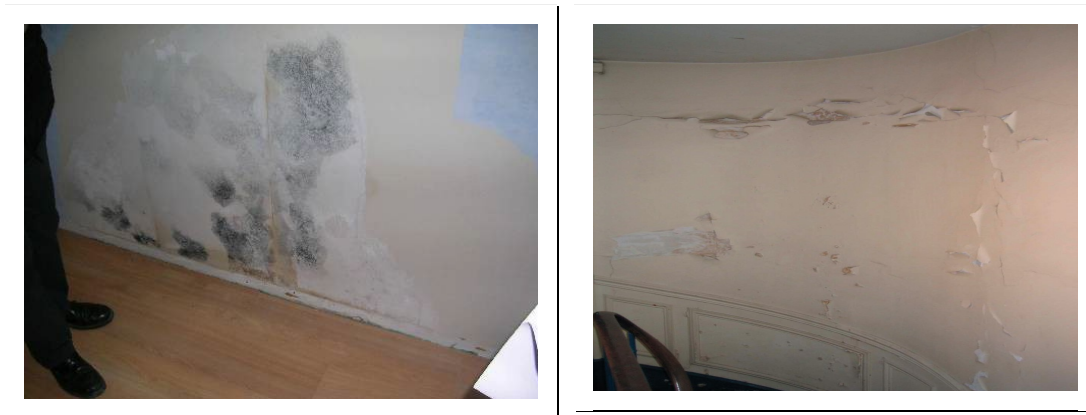
Figure. 3.1. Développement de moisissure
