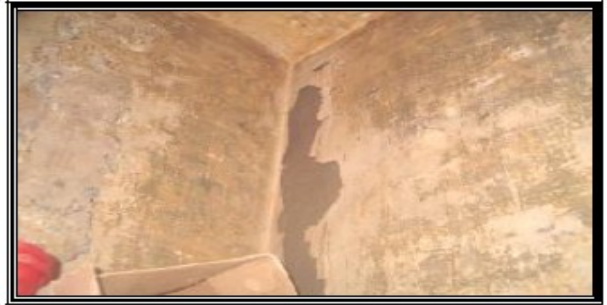
Fig.1.14 : Mouillures.
