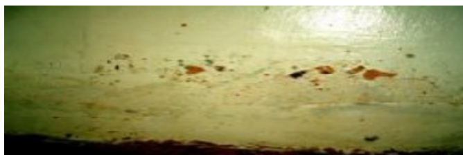
Fig.1.19 : Écaillement de la peinture.
