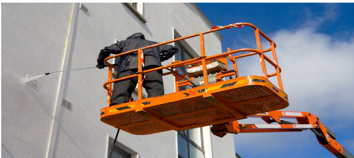
4.7 : traitement d'infiltration par hydrofugation du mur
