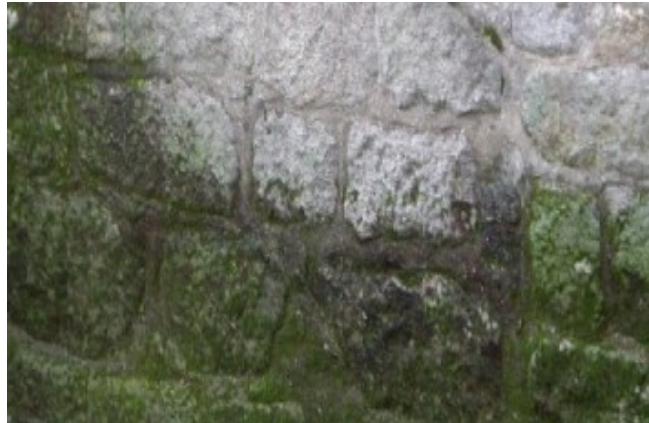
Figure 3.14 : Présence de mousses / à une présence au moins temporaire d'eau
