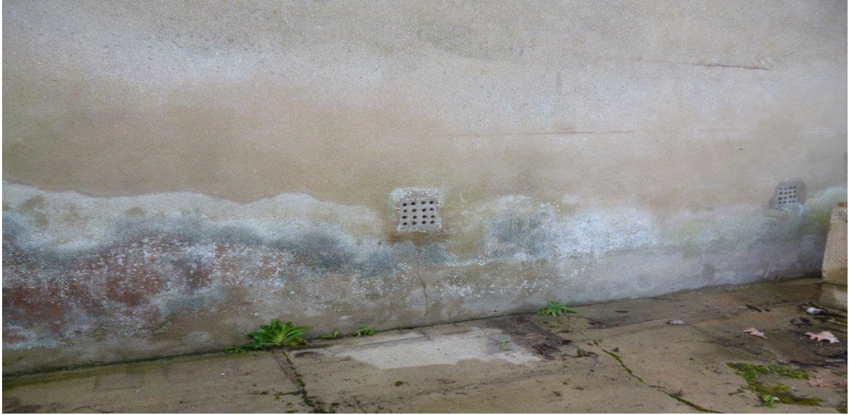
Figure 3.18 : la remonté capillaire dans les murs
