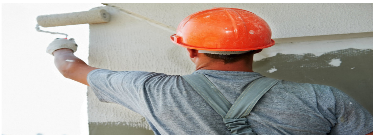
Figure 4.8 : traitement d'infiltration avec de la peinture anti-humidité
