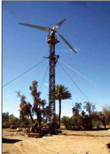
Figure 1.4: Eolienne a axe horizontal (Adrar).
