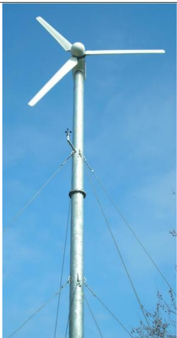
Eolienne de 5 kW sur mât tubulaire haubané 11m
