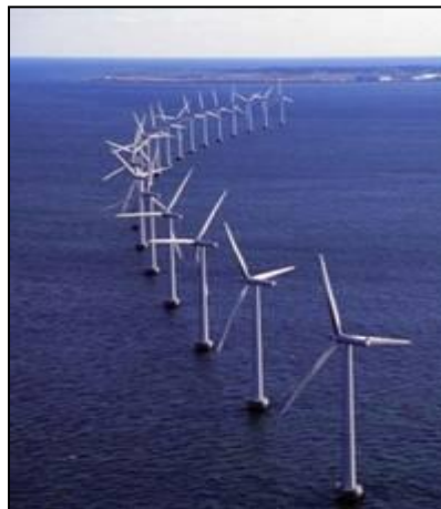
Figure 1.16: Ferme éolienne offshore de Middelgrunden (Danemark). [12]
