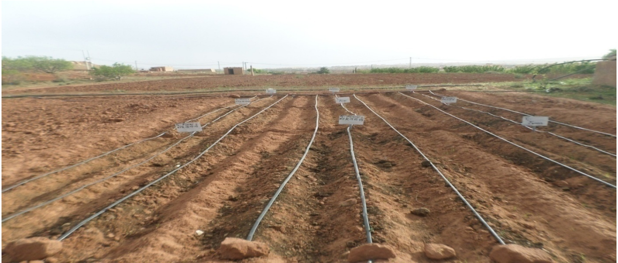
Figure N°34: Installation de système goutte à goutte ( Original )
