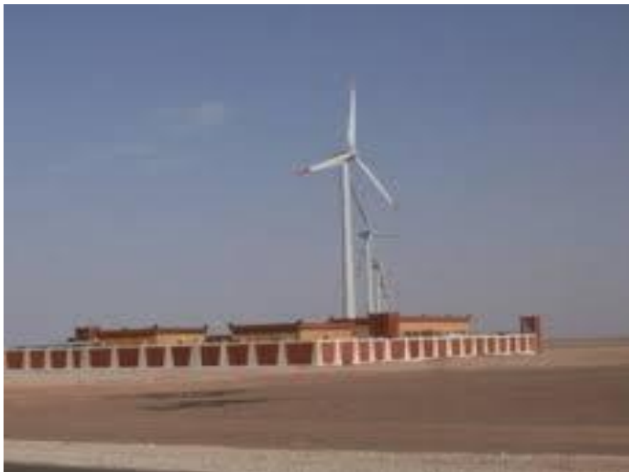
Figure I.10 : Ferme Eolienne de 10MW à Kabertène (ADRAR)
