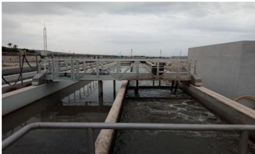
Figure II. 3. Dessableur-déshuileur. (STEP boues activées, Salamandre, Mostaganem).
