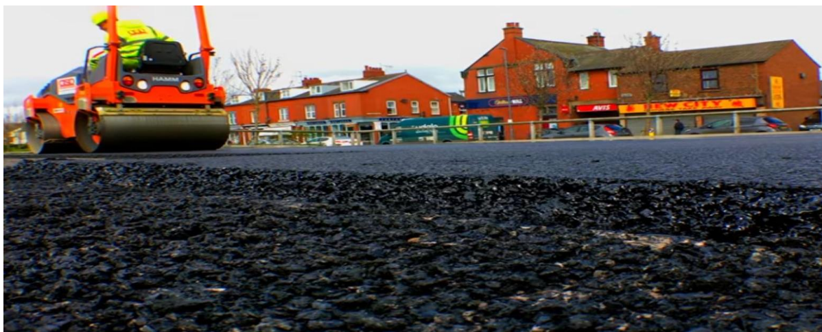
Photo I. 8 : compactage d'un enrobe bitumineux incorporant des déchets plastiques
