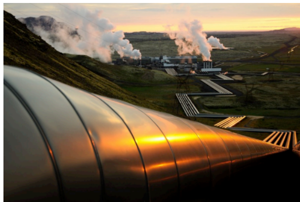
FIGURE 1.7 – Centrale géothermique, Islande (© Fernandez, NCSA)
