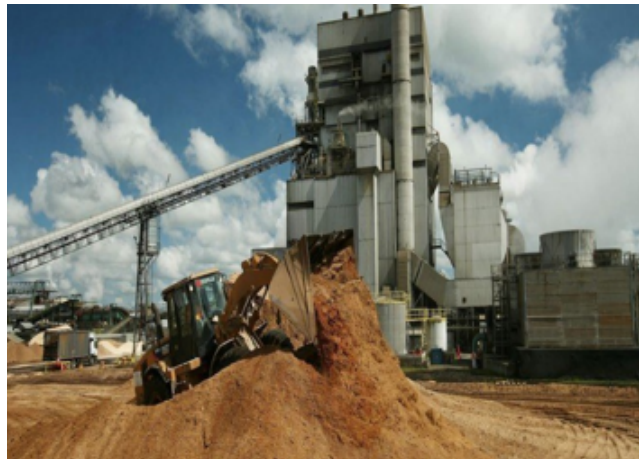
FIGURE 1.14 – Centrale biomasse par énergie chimique (©énergimédia)
