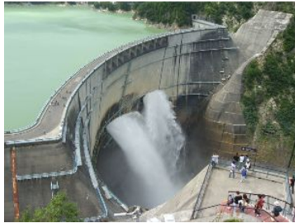
Barrage à énergie hydraulique (©protégeonslaterre)
