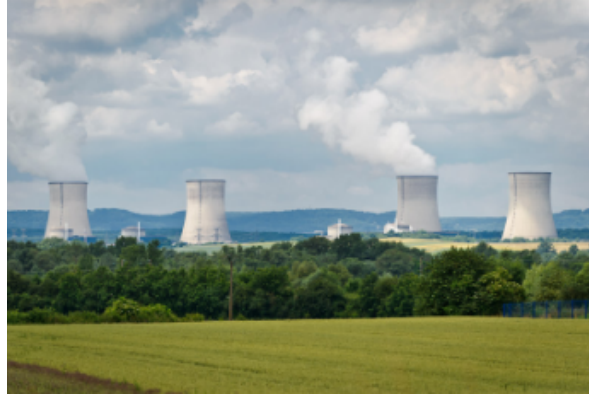
FIGURE 2.23 – Aéroréfrigérant de la centrale de Cattenom, en Moselle. (© A.Bouissou/MEDDE/IRSN)
