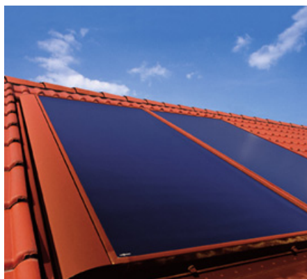
FIGURE 4.5 – capteur plan vitré intégré à la toiture (© Solarpedia)
