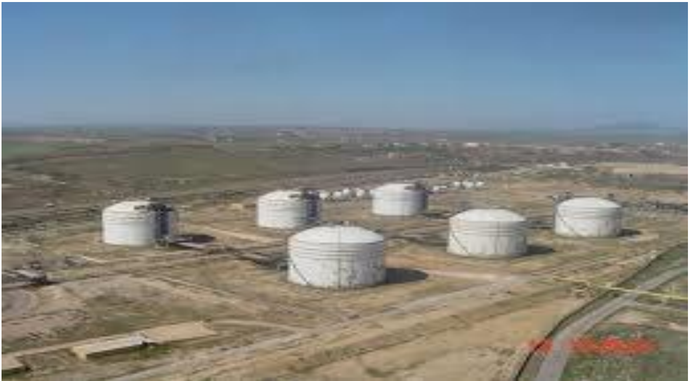
Figure I.7 : Les bacs de stockage (basse température).
