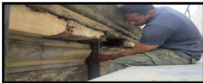
Photo : un ouvrier entrain de poser une conduite en PVC
