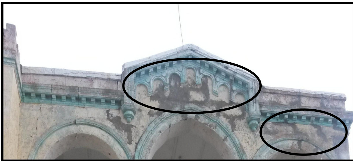
Photo du fronton avec démonstrations des points d'infiltration –source auteur du mémoire–
