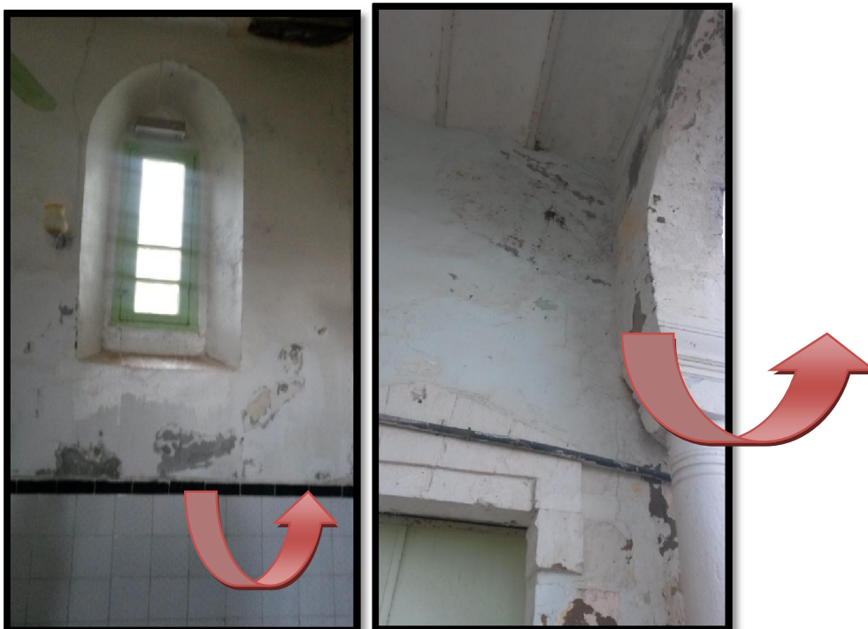
Photo de l'intérieur et de la façade principale– source auteur du mémoire–
