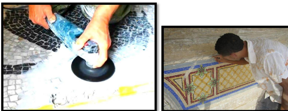
Les différentes étapes de la reproduction des tesselles manquantes
