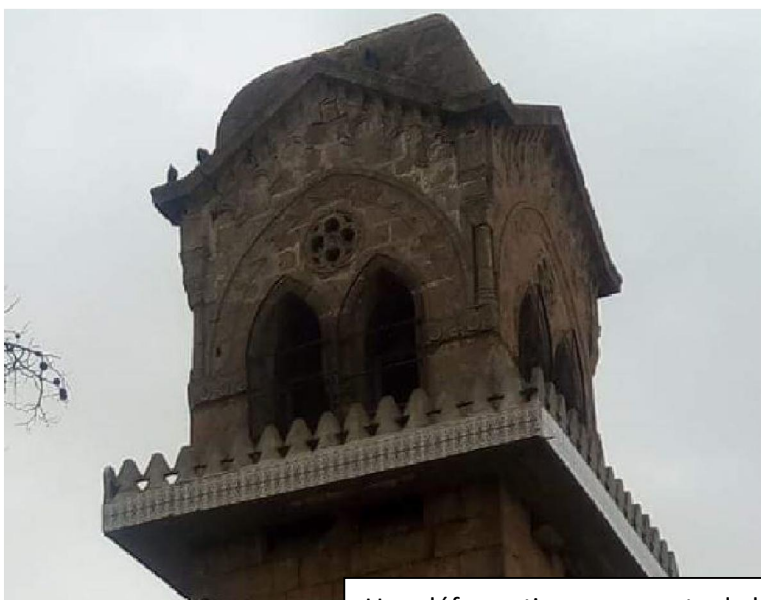
Une déformation marquante de la façade de la tour par l'addition irréfléchie du balcon cachant les fenêtres brisées et la rosace de
