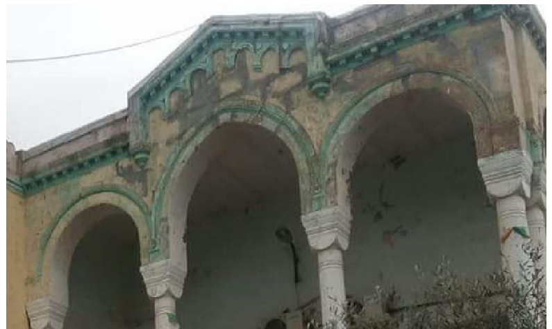
Portail principal avec deux arcs en plein cintre et un arc brisé central, soulevés par des colonnes à chapiteaux simplistes
