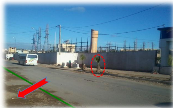
Figure19: trottoir non structuré
