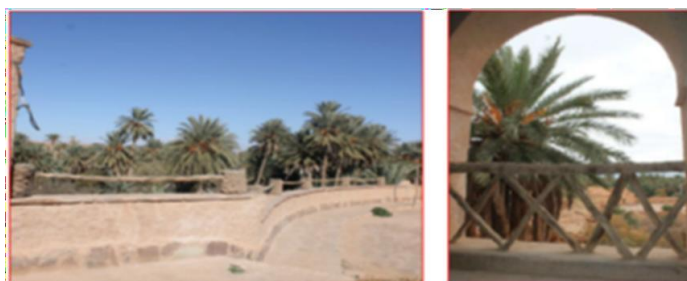
Photo 51: Les balcons du ksar de Boussemgoun (Ait SAADI)
