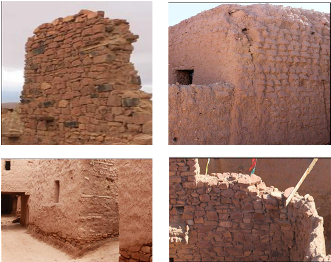
Photo 43: Détail des murs porteurs
