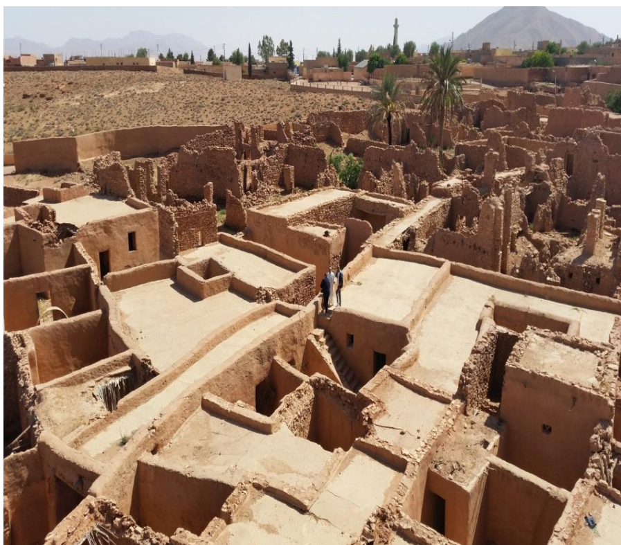
Photo 55: Vue sur le Ksar et état de dégradation
