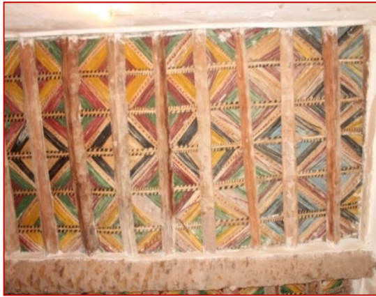
Photo 38: Éléments décoratifs du plafond de la Zaouia du ksar de Boussemgoun
