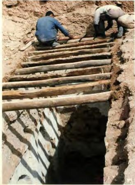
Photo 4: Réalisation du passage couvert
