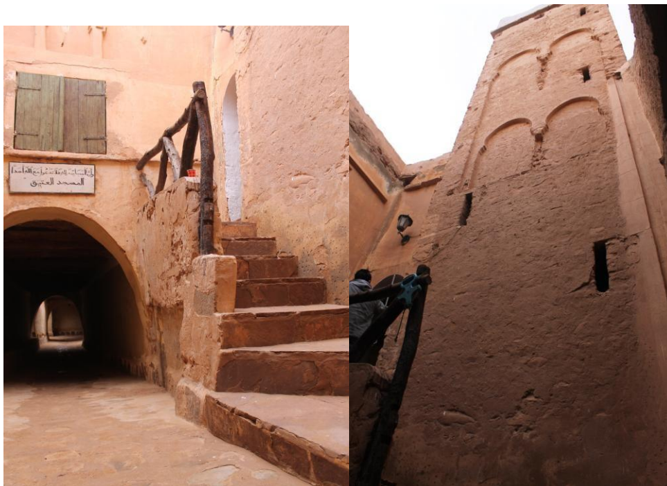
Photo 36: Vue de la rentrée principale de la mosquée et du minaret du ksar de Boussemhoun
