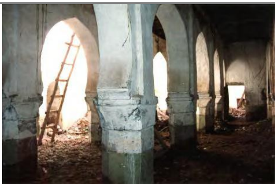
Photo 7: Salle de prière avant restauration
