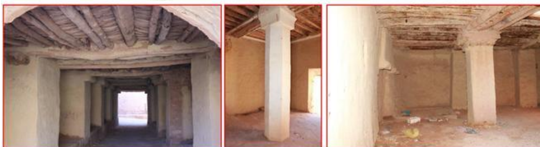
Photo 45: Détail des murs porteurs
