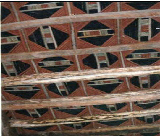
Photo 6: Restauration du plafond
