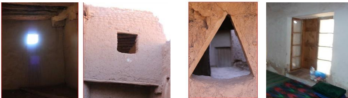
Photo 49: Les différents types d'ouvertures du ksar de Boussemgoun (Ait SAADI)
