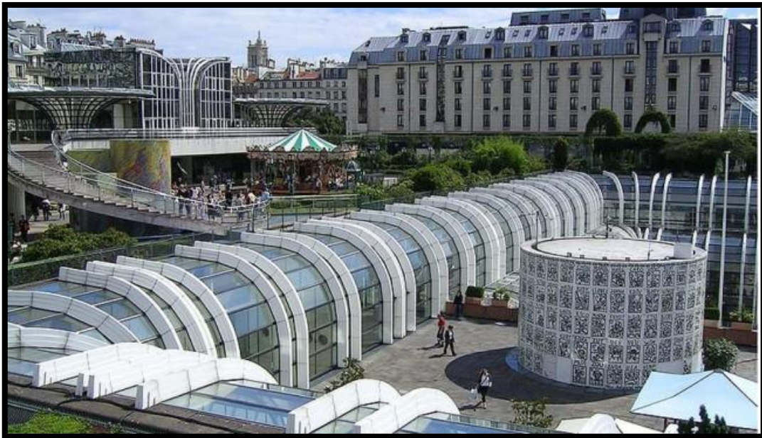
Figure 4: Hollos, A. (1985) : Sur le parvis du Forum des Halles : la superstructure. Dans : Travaux, n. 600 (juin 1985), pp. 34-45 Paris, France
