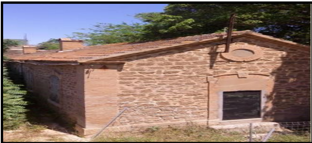
Figure 100 : Caserne (BATIMENT historique/ source : Auteurs de mémoire
