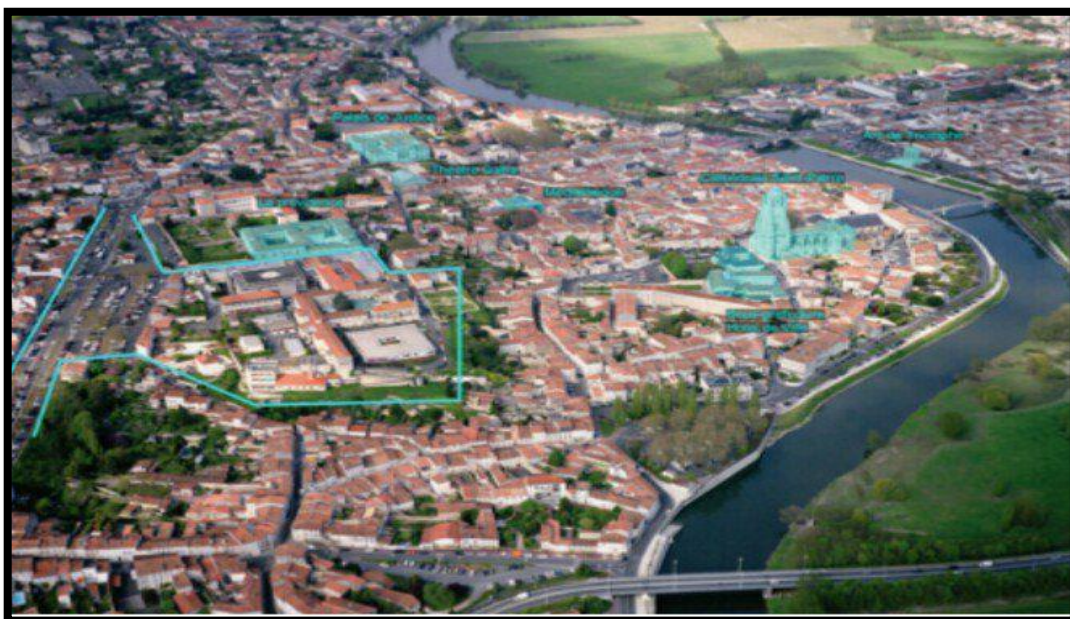
Figure 61: Site du projet de Saintes
