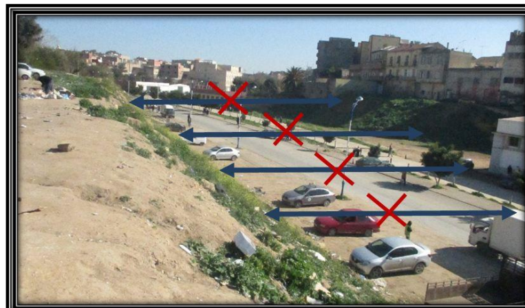
Absence de liaison entre les rives
