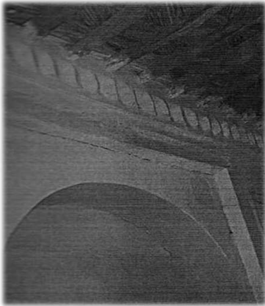
Figure 30: Photo Mosquée el Atiq du ksar de Beni ouunif
