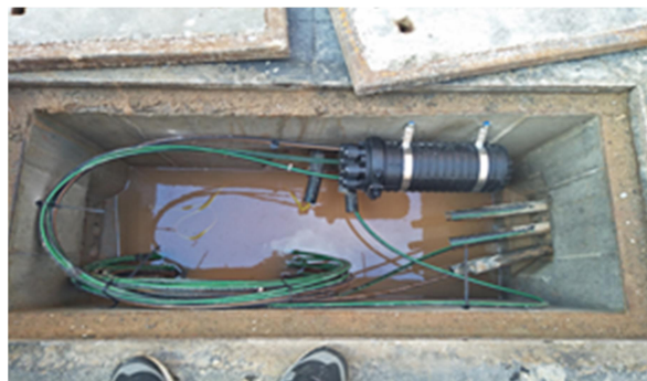
Figure 4.34 : Placer la closure dans la chambre A3.
