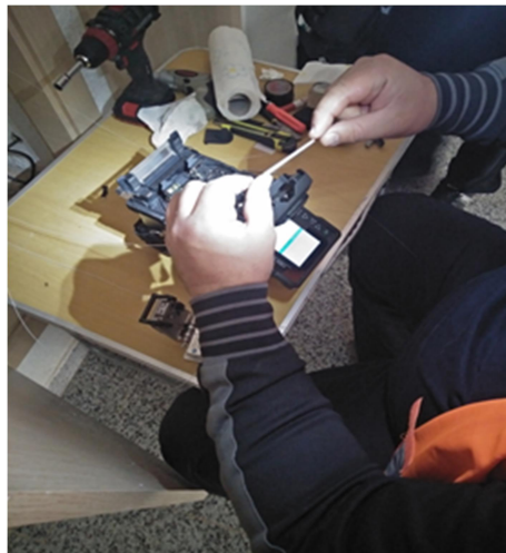
Figure 4.48 : Placement de la gaine sur les fibres soudées.
