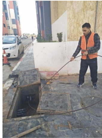
Figure 4.35 : Le tirage de câble.
