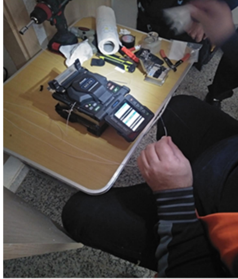
Figure 4.43 : Nettoyage de la fibre.
