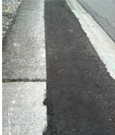
Figure 4.15 :Remblaiement de la tranchée
