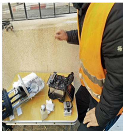
Figure 4.31 : Soudage à la fibre.
