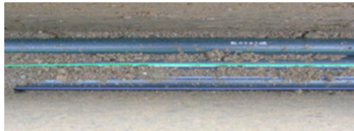
Figure 4.13 : La pose de fourreaux en PEHD.
