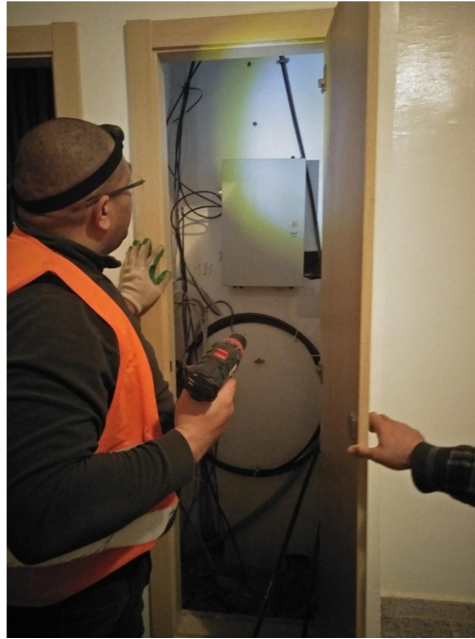
Figure 4.37 : Placer le FDT dans la place réservée.
