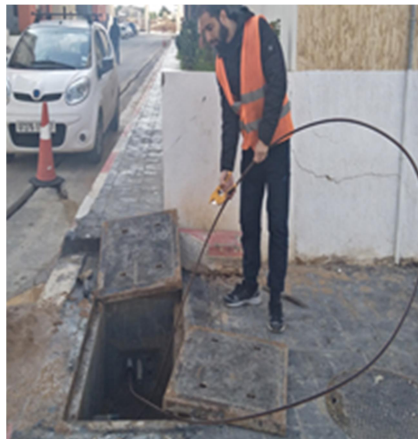
Figure 4.20 : Pose des câbles de F.O.
