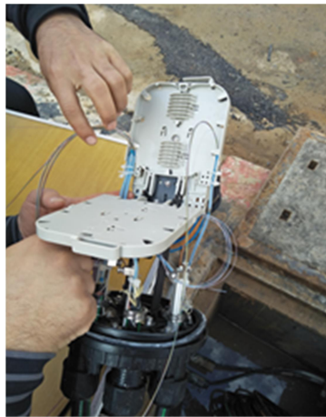
Figure 4.30 : Ouvrez la boîte et insérez les câbles.
