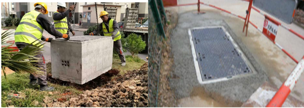
Figure 4.19 :Pose de chambres préfabriquées.
