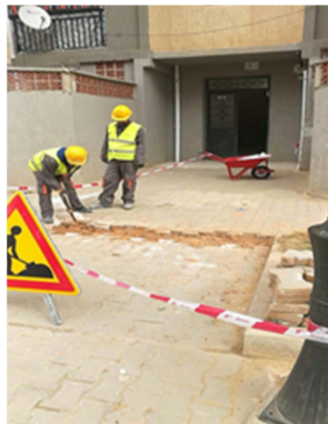
Figure 4.10 : Signalisation et sécurisation du chantier.
