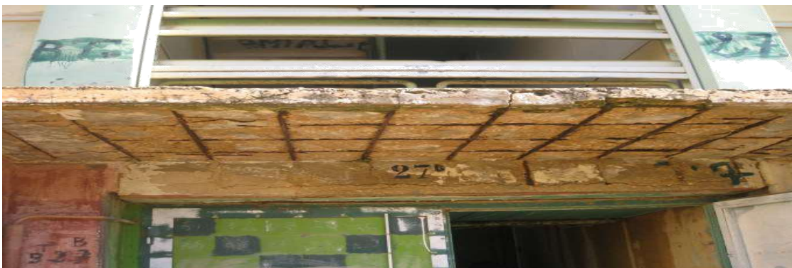
13- Dalle d'un auvent d'entrée complètement dégradée.
