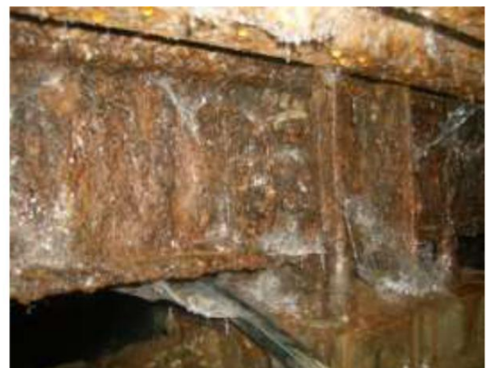
9- état d'un appui sous l'effet de l'eau
