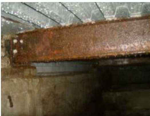
8-Condensation en sous face du plancher
