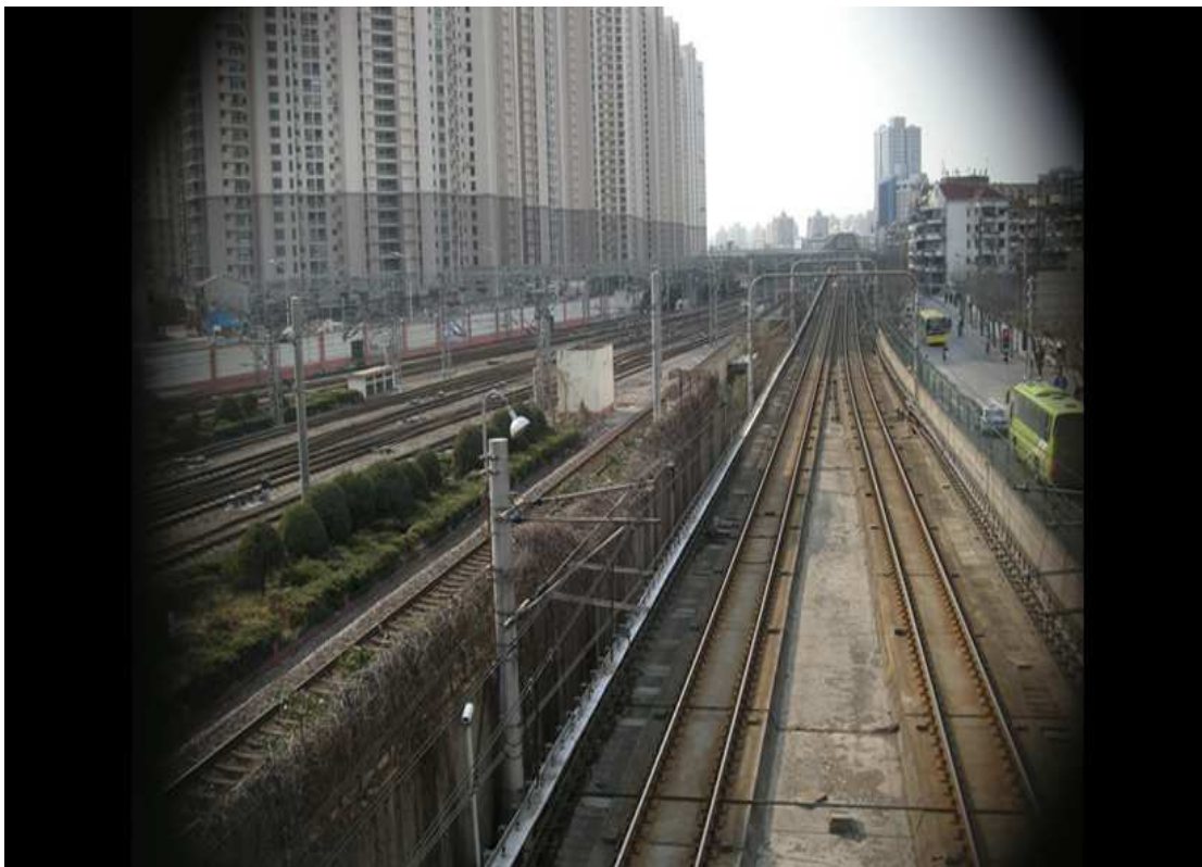
Photo n°29: une infrastructure rupture
