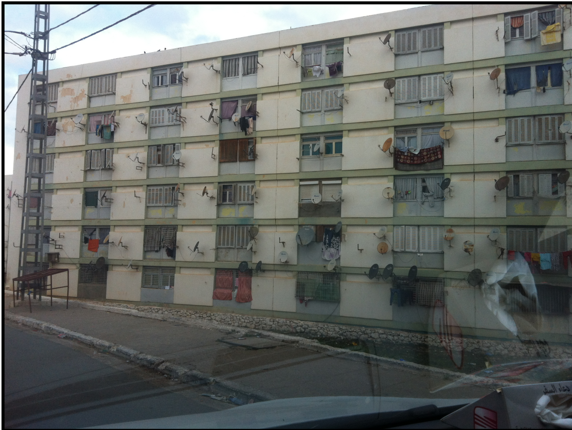
Photo n°05 : Habitat collectif moderne
