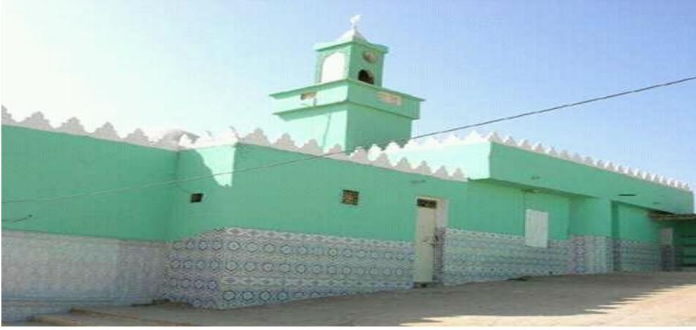
مسجد سيدي بلمهل
