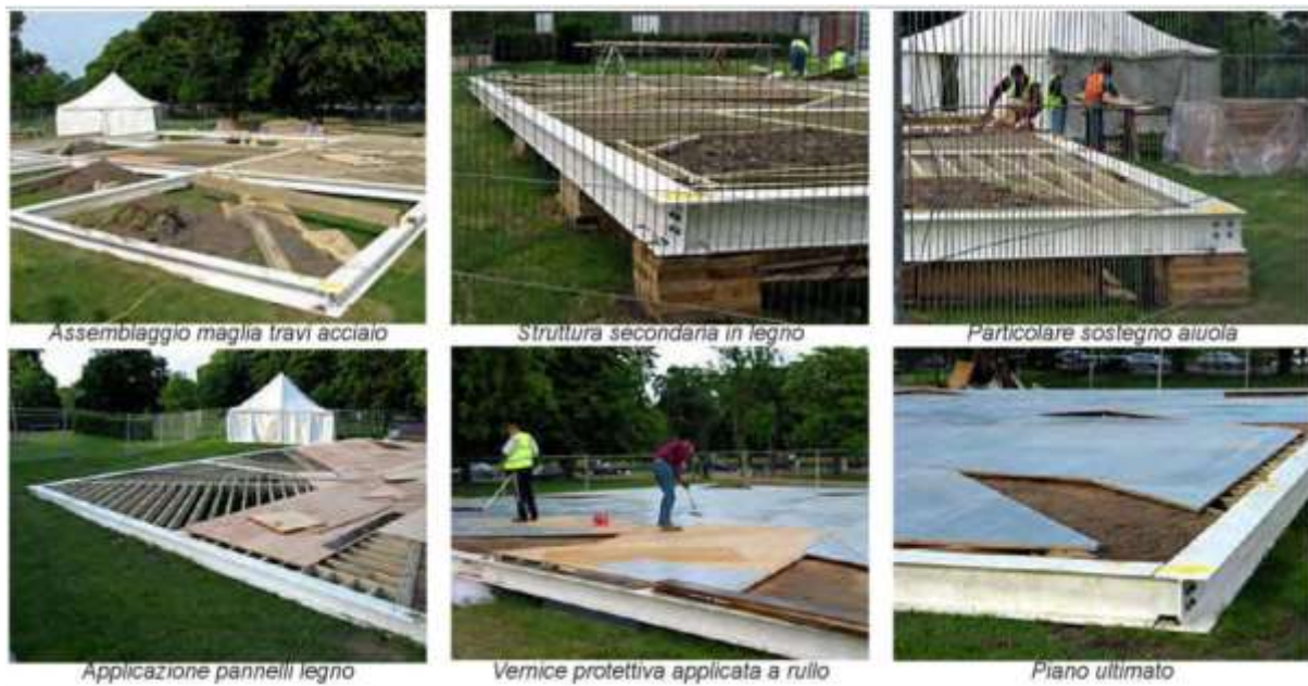
Figure 125 : PHASE 1 de construction de pavillon
