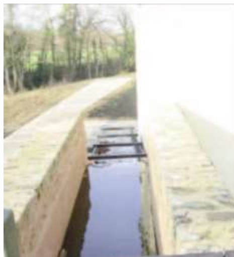
figure 109 : le canal d'amenée
