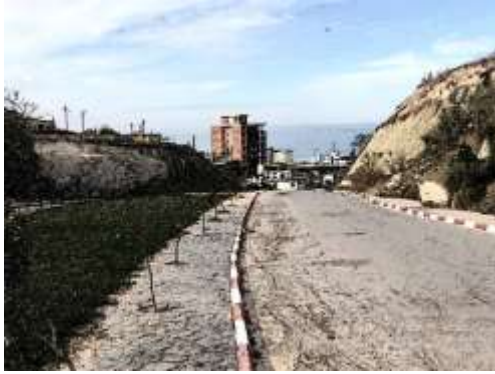
Séquence 7 liaison entre les parcoure existant ouverture
