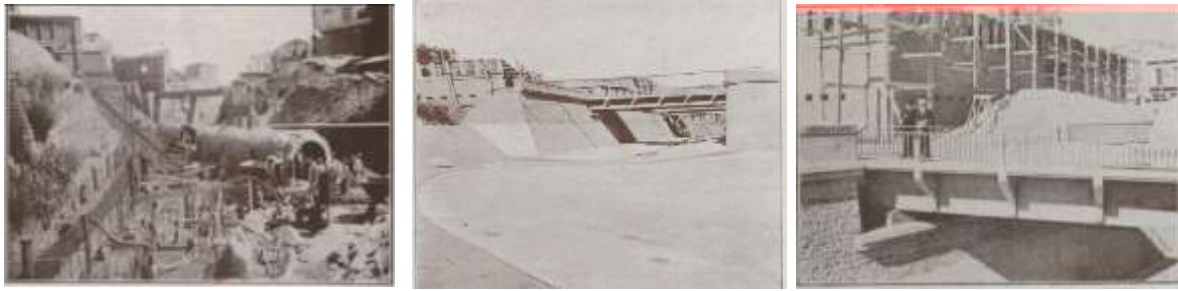
Figure 31 : travaux construction après la crue d'Oued Ain-Sefra
