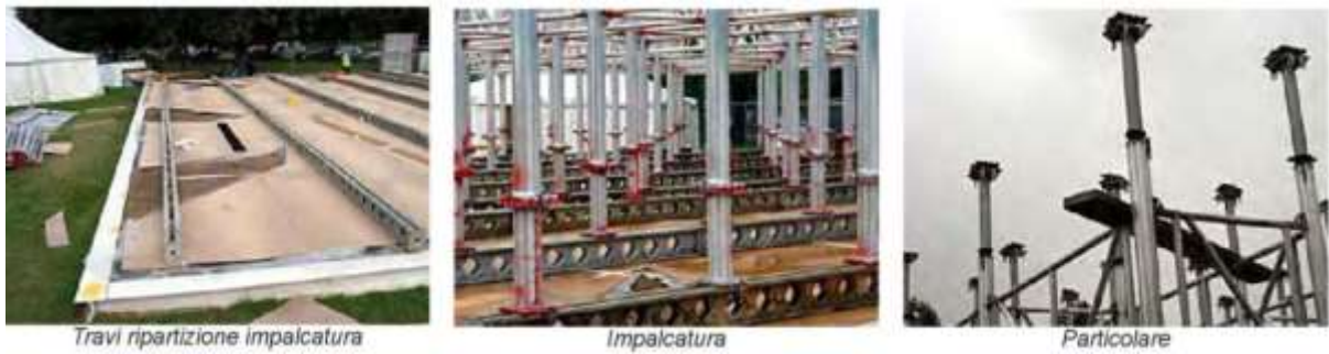
Figure 126 : PHASE 2 de construction de pavillon
