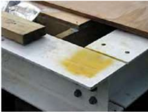
Figure 118 : Détail du joint boulonné entre deux sections d'angle de la base de support. Les profilés arrivent sur chantier y compris les profilés de jonction et les trous pour le montage
