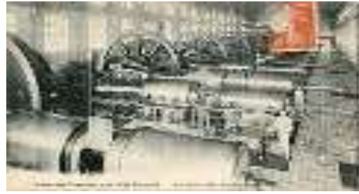
Figure 39 : d'une Dynamo donnant l'éclairage électrique
