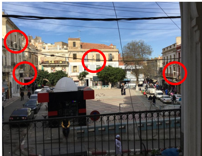
Figure 12 Distribution du réseau d'éclairage public au niveau de la place. Source auteur Février 2017
