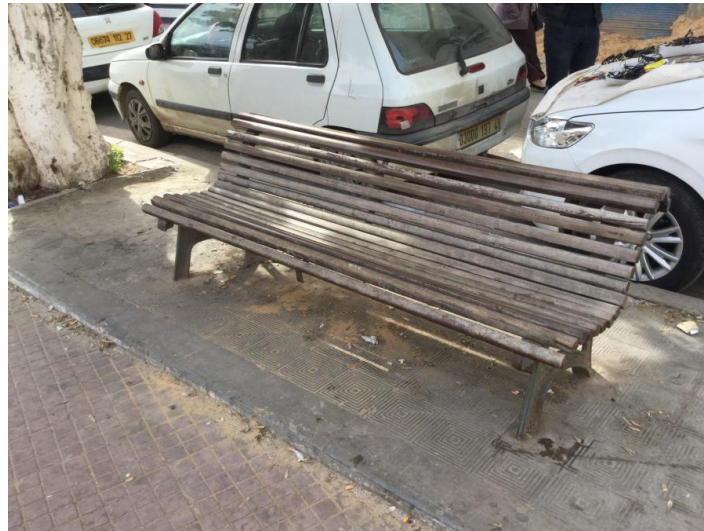
Photo 36 Etat du mobilier urbain (Banc) au niveau de la place. Source auteur Février 2017
