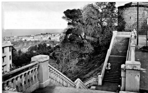
Photo 18 Escaliers de la Marine Source : association-mostaganem.com
