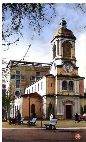
La construction de la Sacristie sur la place de la République Source Delacampe.net
