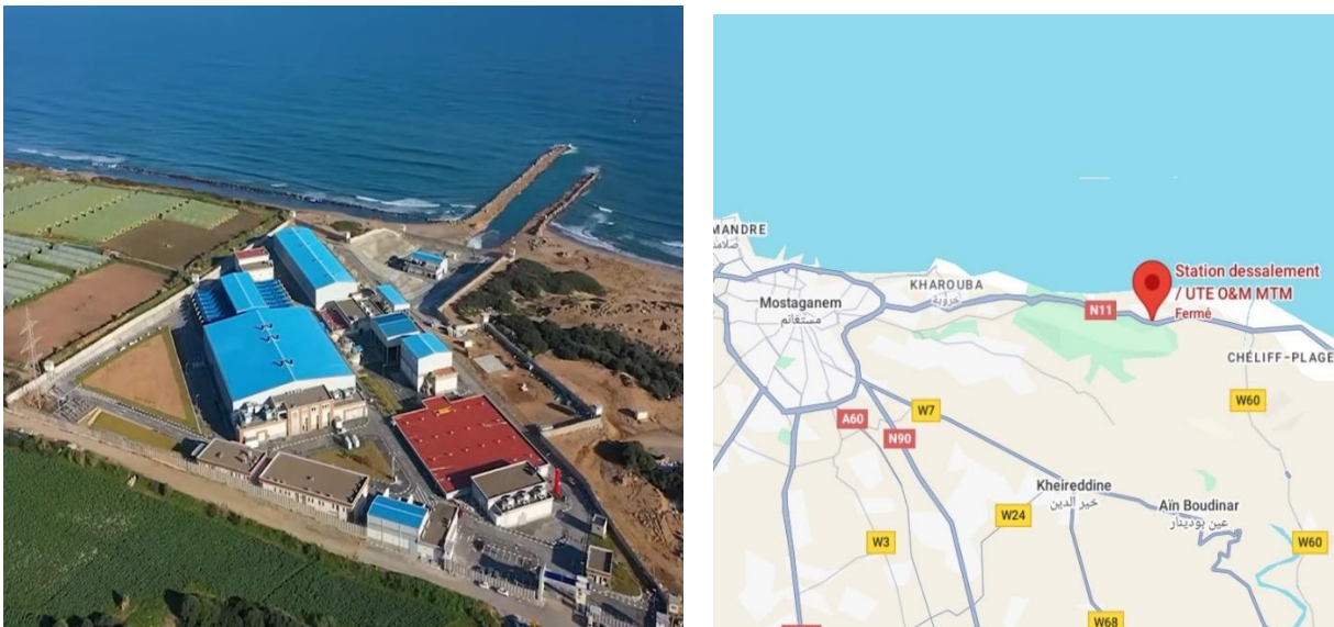
Figure II-1 : Vue générale et situation géographique de la station de dessalement
