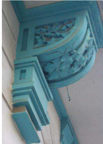
Photo 14 Ornement de taille moyenne : Corbeau sous le balcon filant
