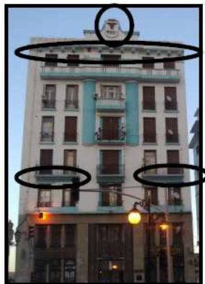
Photo 10 Nombre des ornements de la façade de BNCI
