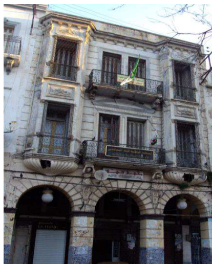
Photos 19 :Vue de la façade de l'immeuble d'habitation.
