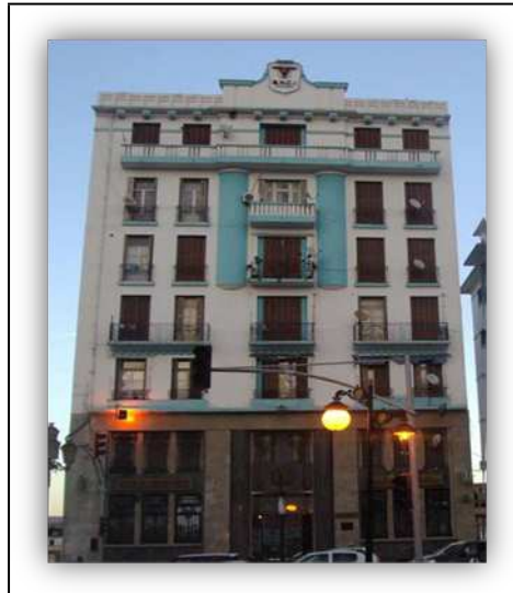
Photo 8 Vue de l'immeuble du Banque nationale pour le commerce et l'industrie
