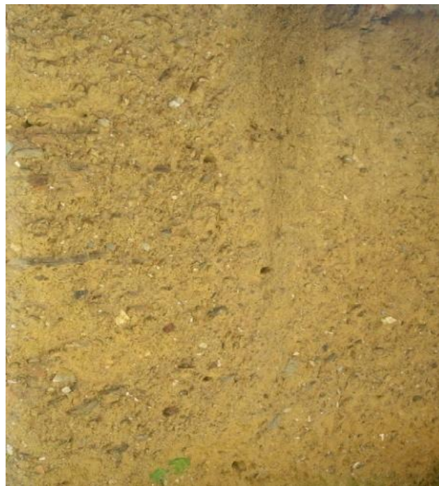
Figure III.16: Mur en pisé à Thala Hammou - Mâatkas [Auteur].
