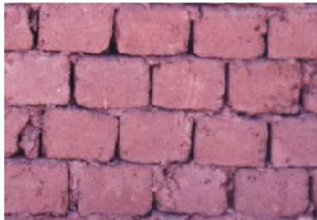
Figure III.05: Mur en thoub (région de Boughzoul) [Kebaili, 2006].
