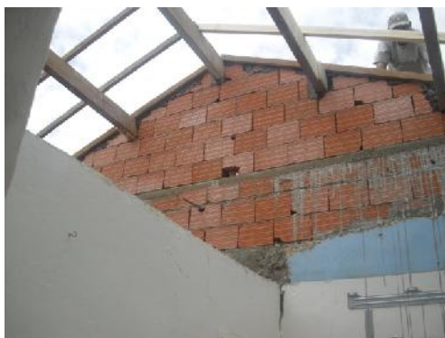
Figure IV.20: Construction d'une charpente en bois.
