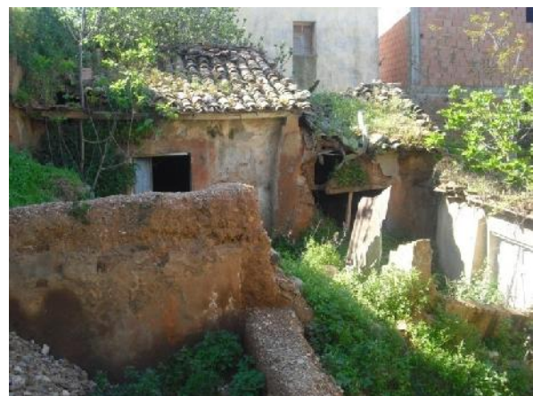
Figure I.11: Maison abandonnée à Ait Hmad - Maatkas [Auteur].
