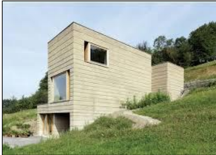
Figure III.21: Maison de Martin Rauch [Martin Rauch, site internet].
