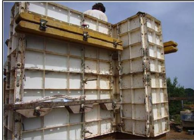
Figure III.23: Coffrage métallique du pisé moderne sur un chantier en France. [Bui, 2008]
