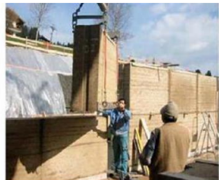
Figure III.25: Transport et mise en œuvre des éléments préfabriqués [Rauch, 2007].
