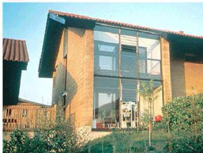
Figure II.02: Des maisons mitoyennes en blocs de terre vibro-compactée [Kebaili, 2006].
