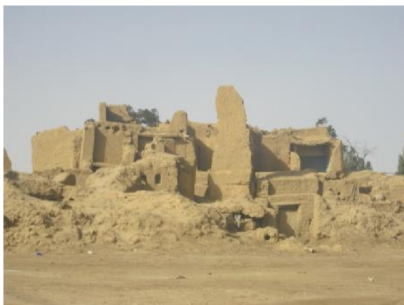
Figure I.10: Ksar en ruine à Biskra [Auteur].
