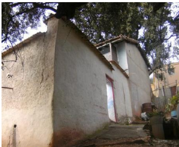
Figure III.11: Fissures au niveau des angles et des baies à Ait Itchir [Salmi, 2014]
