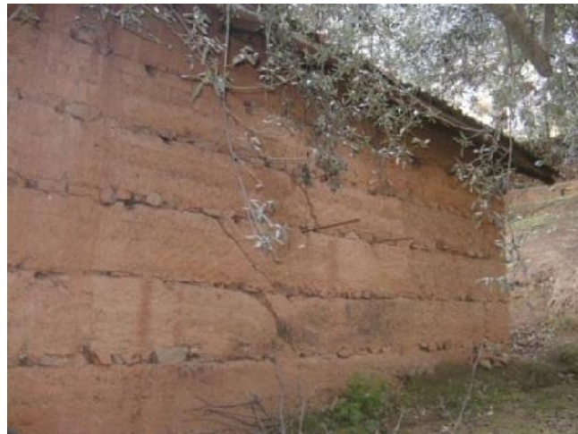
Figure I.20: Maison en terre à Ait Itchir en Kabylie [Salmi, 2014].
