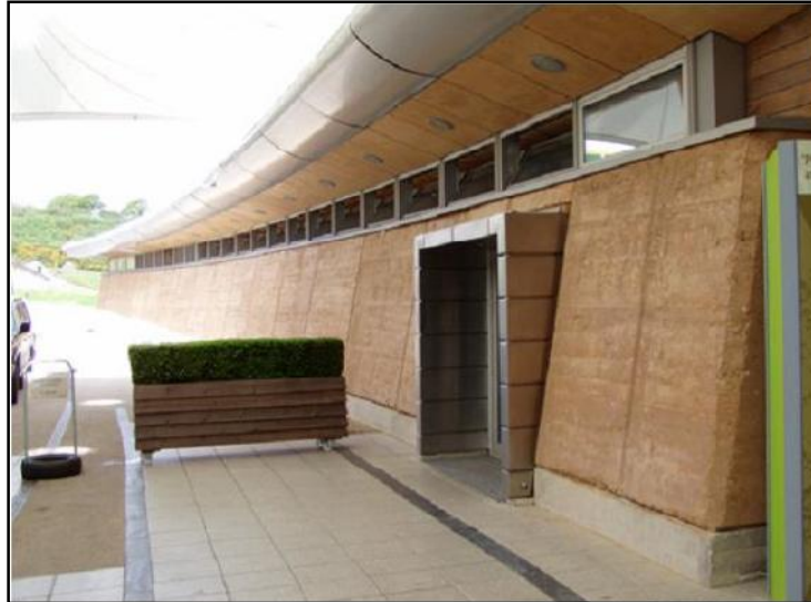
Figure III.15: Bâtiment en pisé stabilisé au ciment [Maniatidis, 2003].
