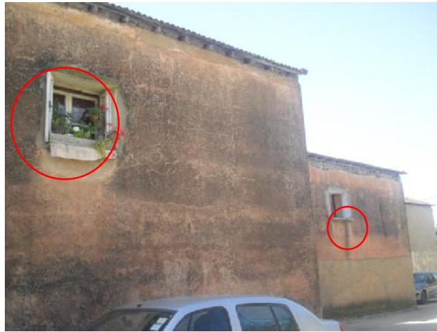
Figure IV.22 : Création d'une fenêtre sur la façade nord-ouest.
