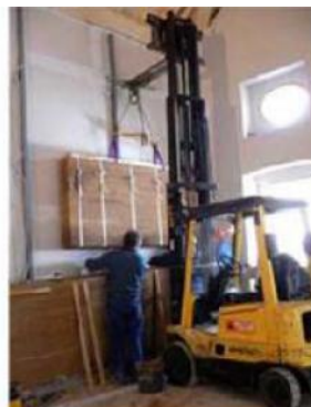
Figure III.25: Transport et mise en œuvre des éléments préfabriqués [Rauch, 2007].
