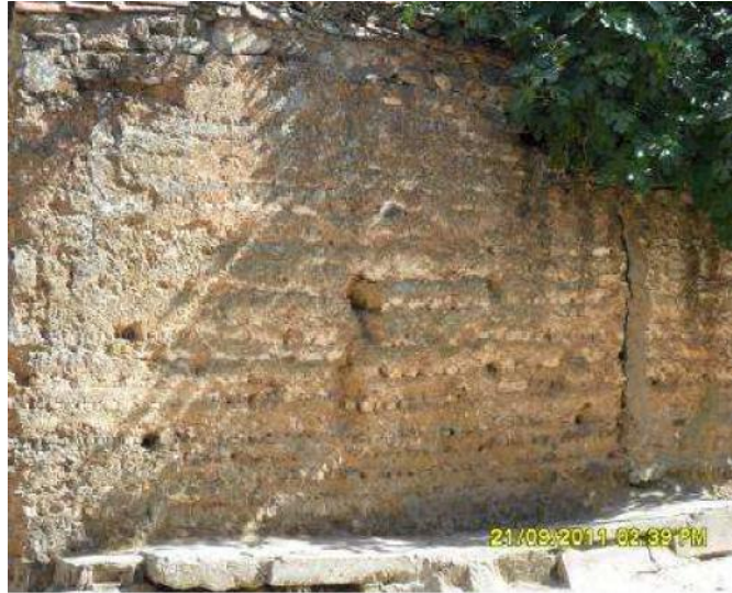
Figure III.04: Mur en pisé à Beni Yenni [Idir, 2013].
