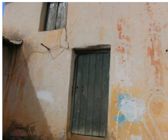
Figure III.11: Fissures au niveau des angles et des baies à Ait Itchir [Salmi, 2014]
