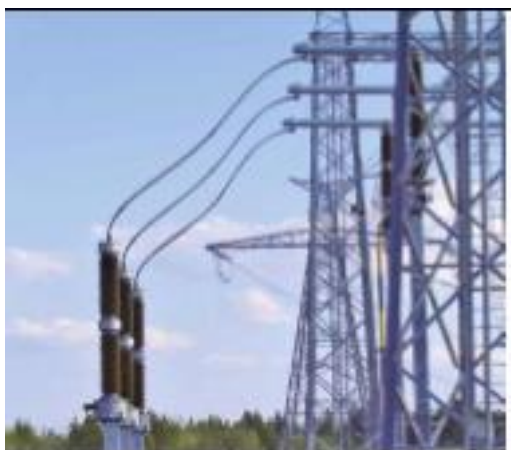
Figure II-4 : Schéma d'un Transformateur de tension
