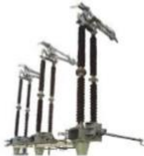
Figure II- 6.2 : Sectionneur de mise à la terre
