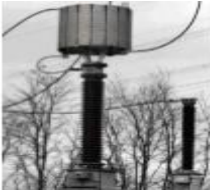
Figure II- 8: Photo réelle de circuit bouchon
