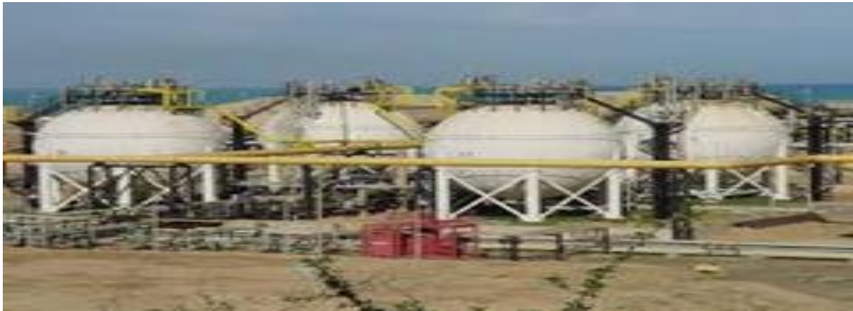
Figure I.3. Les sphères de la charge d'alimentation du GPL1/Z [2].
