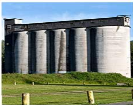
Photo 2 : silos en béton.
