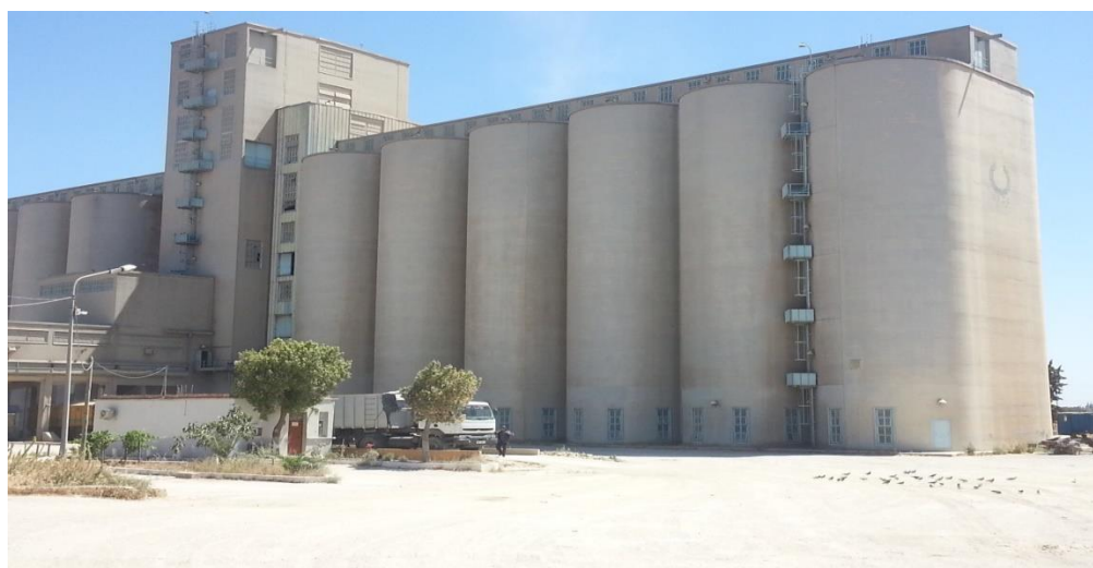
Photo 7: les silos du stockage de blé tendre.
