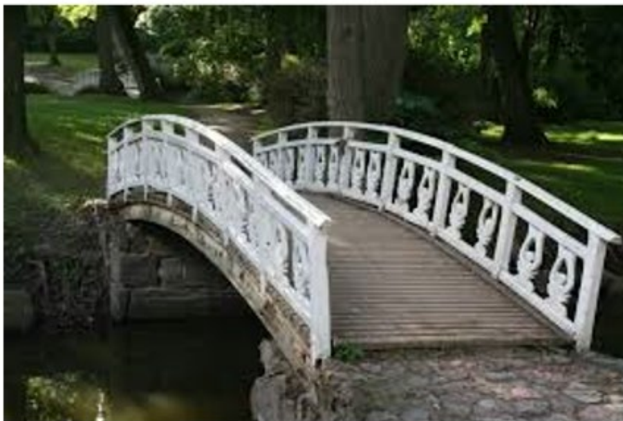
Figure 33: pont du parc bridge
