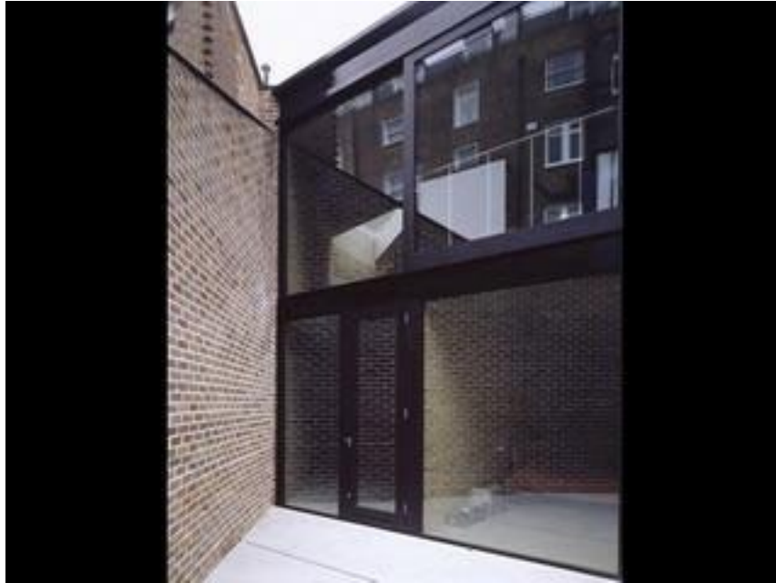
Figure 47: vu extérieur de l'entrée et façade principale du projet
