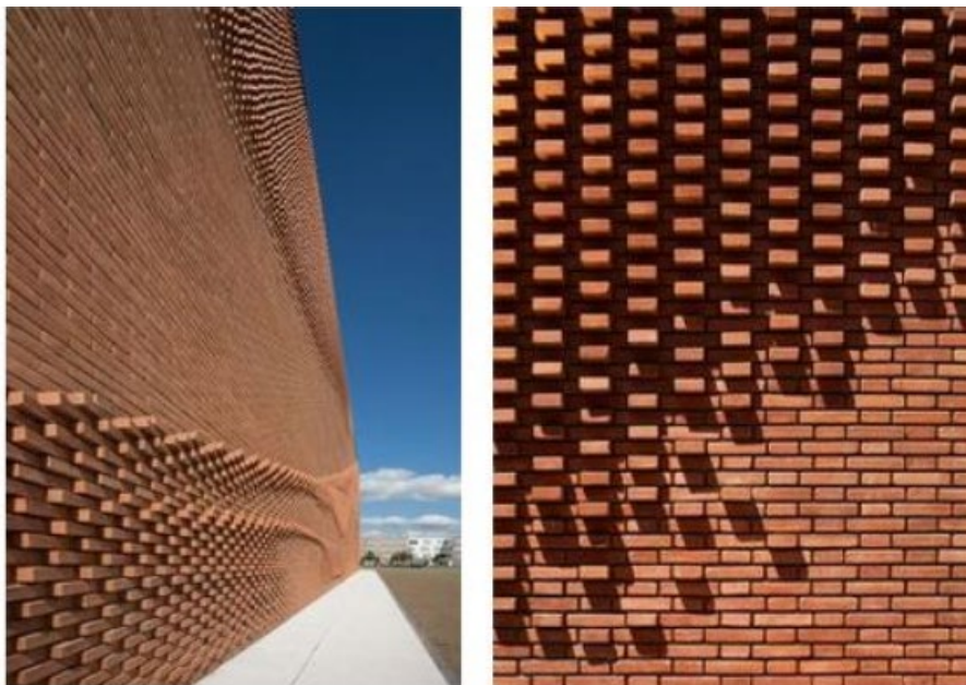
Figure 73: Exemple appareillage de brique
