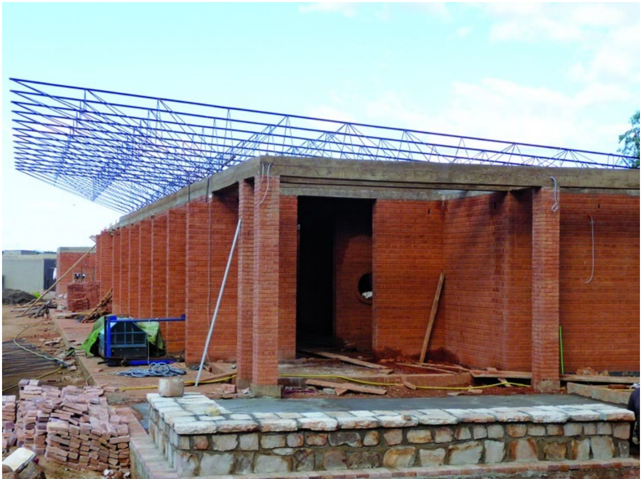
Figure 58: TOITURE EN CONSTRUCTION
