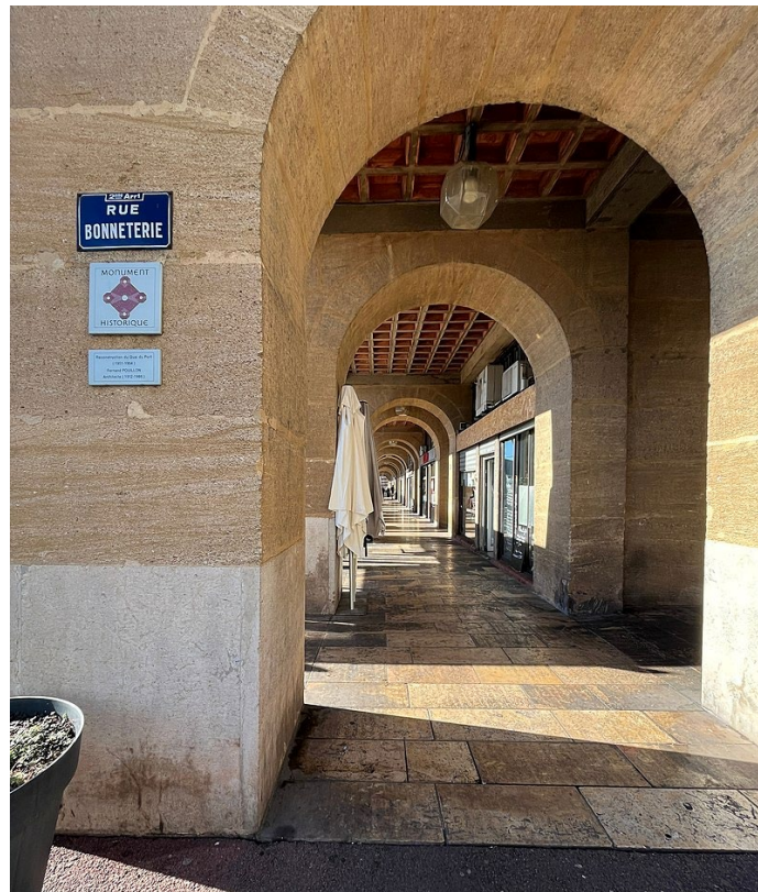
Figure 45: Vue du portique au rez-de-chaussée de l'immeuble
