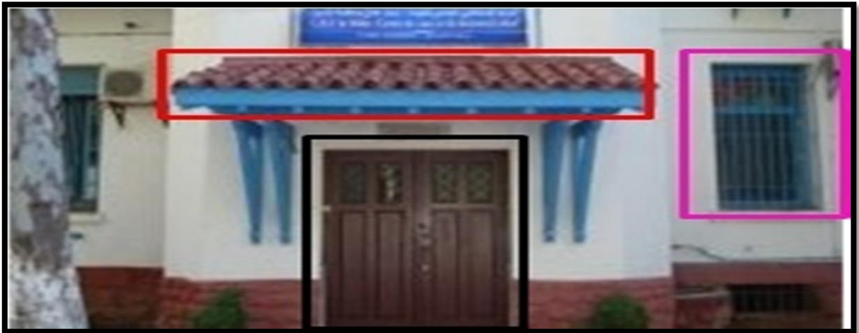
Figure 22 : façade principale du centre
