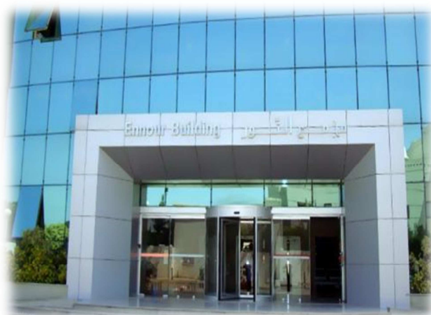
Figure 32 : entrée principale centre anti tabac de tunis Source : http// : www.ennourbuilding.com
