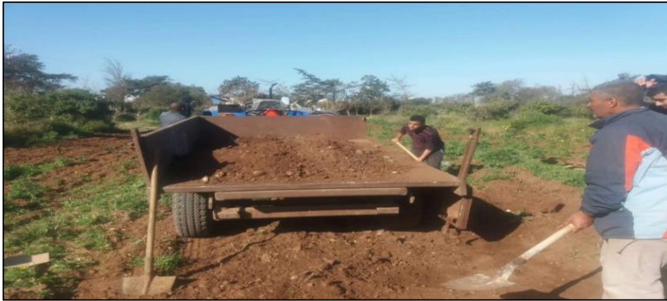
Photo 10 : le transport de la terre végétale
